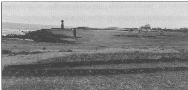
Рис. 63. Каменный фундамент «дома-лодки»
