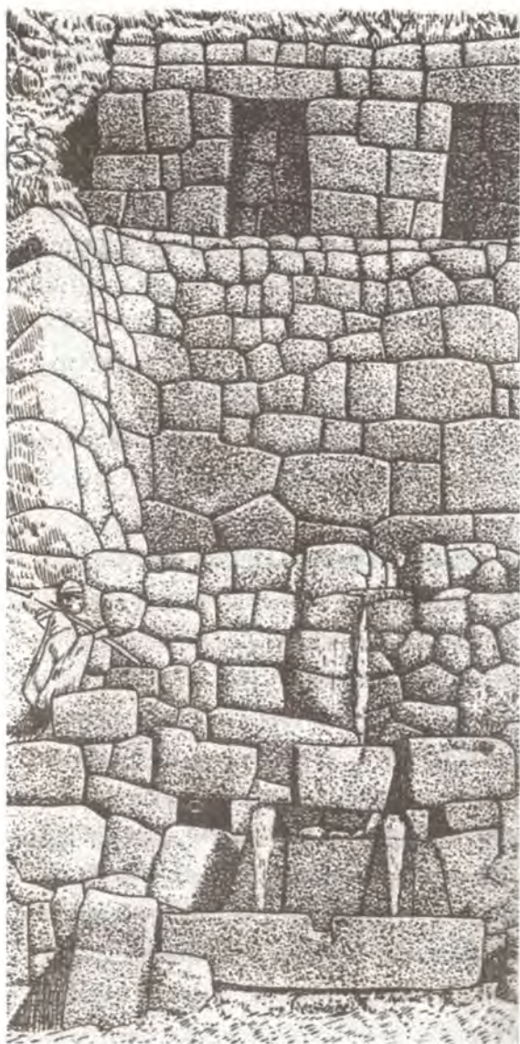
Кладка стен, покрывающих склон холма в Тамбомачай
