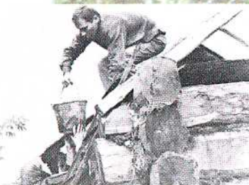
На строительстве летней кухни. Лето 1966
