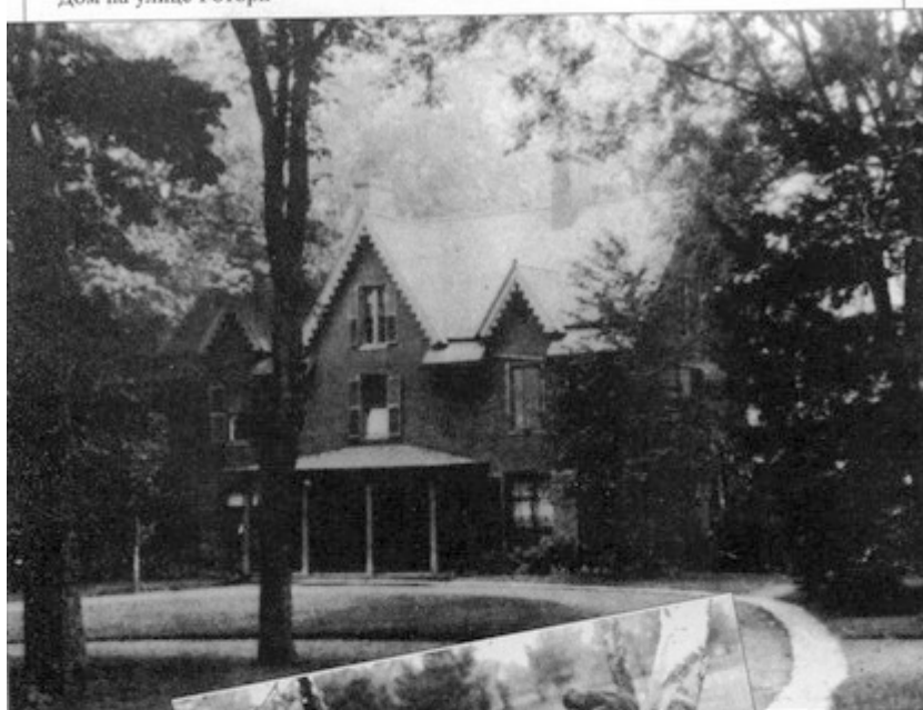
Дом на улице Готорн
