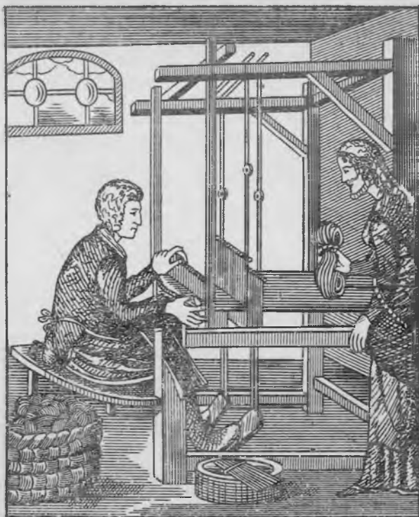
Фламандский ткацкий станок середины XVI века
