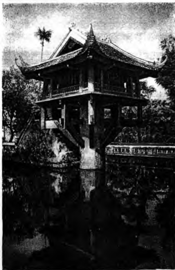
32. Общий вид храма Эьен-Хыу после реставрации
