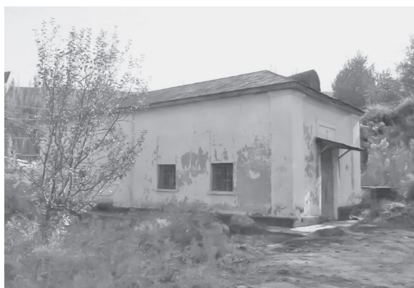
ГЭС-8. Здание ГЭС
