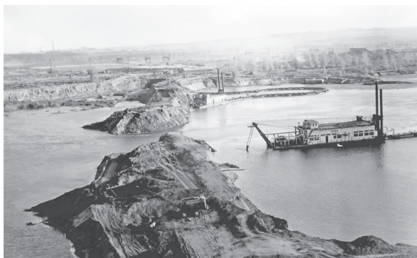
Разборка низовой перемычки котлована ГЭС земснарядом после его затопления
