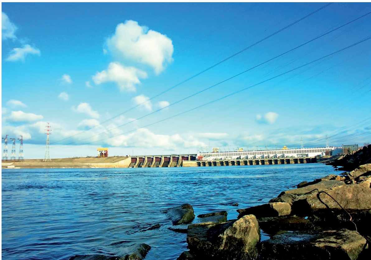
Воткинский гидроузел. Общий вид водосливной плотины и ГЭС с левого берега Камы
