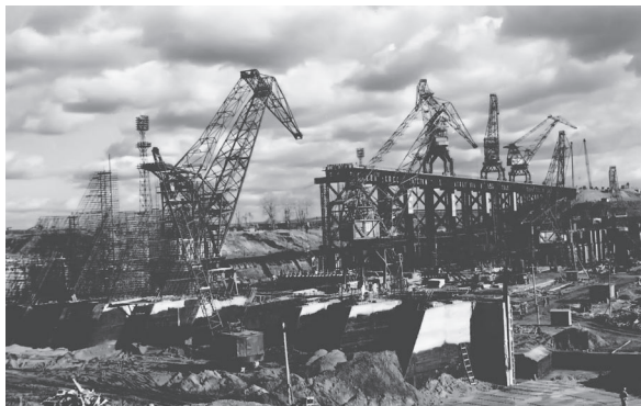
В котловане ГЭС. Монтаж арматуры, опалубки, укладка бетона портальными кранами
