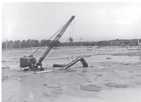
Намыв грунта (пульты)
