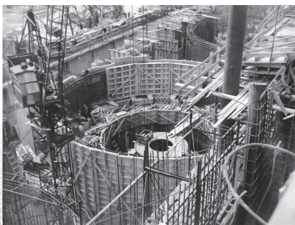
Опалубка с арматурой, подготовленные к укладке бетона
