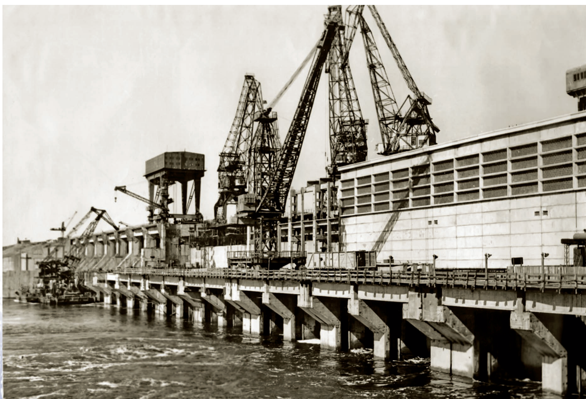
Воткинский гидроузел. Вид на строящуюся водосливную плотину и гидростанцию
