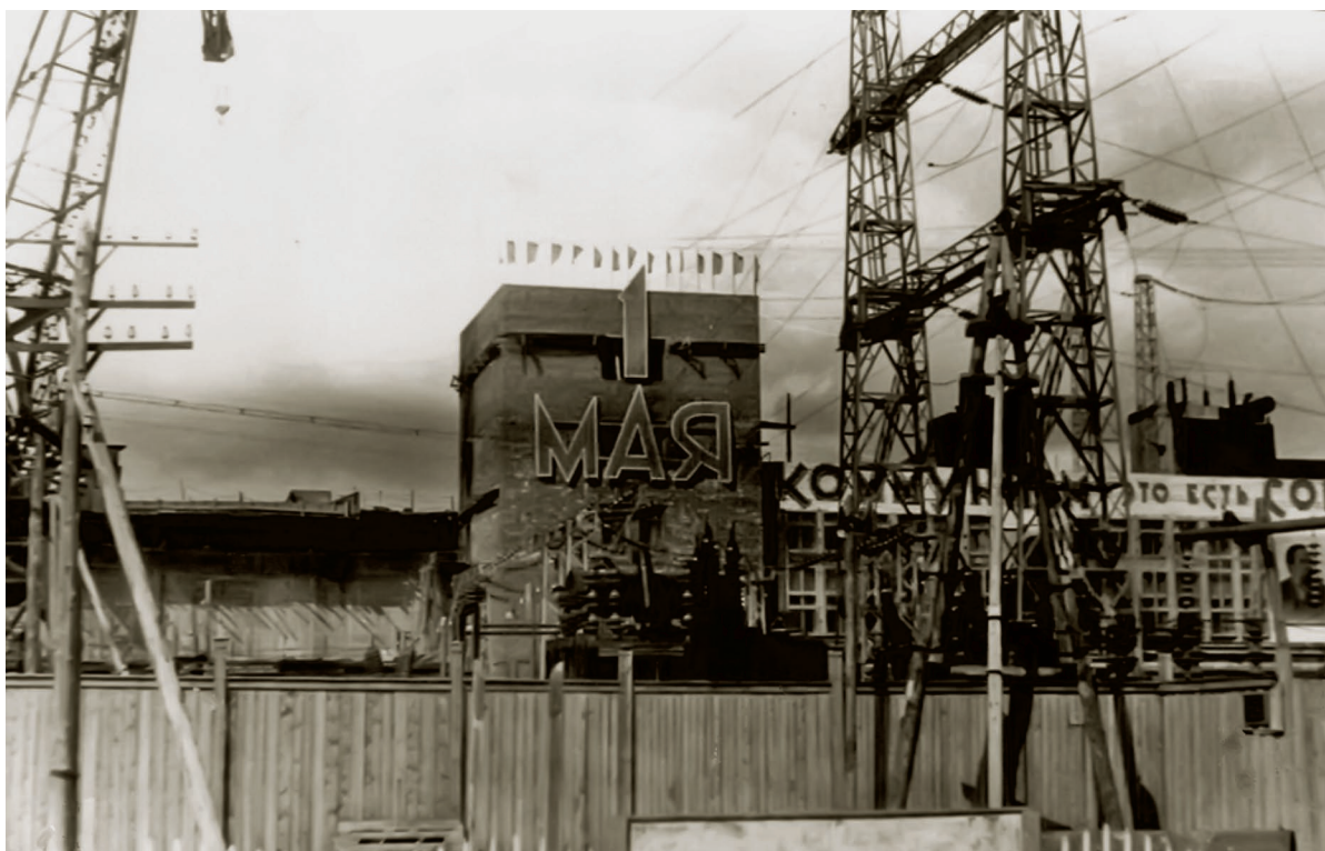
Камский гидроузел. Водосливная ГЭС, 1955 год
