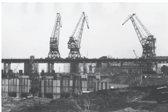
Портальные краны г/п 15 тонн, вылет стрелы 40 м фирмы «Эберсвальде» на бетоновозной эстакаде
