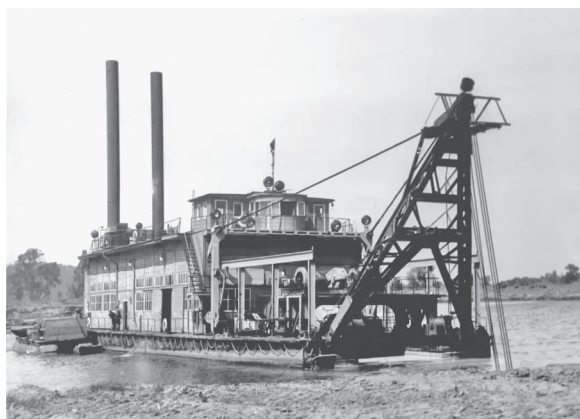
Земснаряд. Разработка грунта
