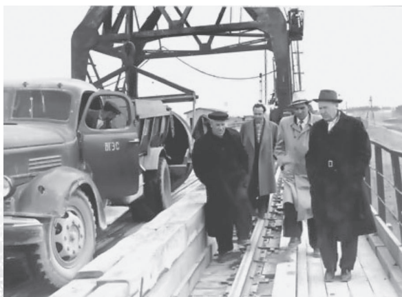
Бетоновозная эстакада ГЭС.
