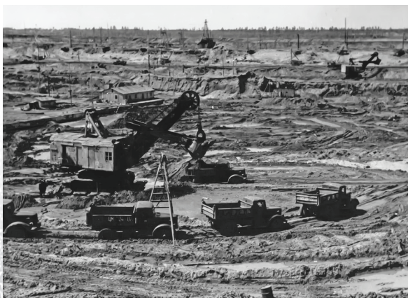
Выемка грунта экскаватором из котлована ГЭС
