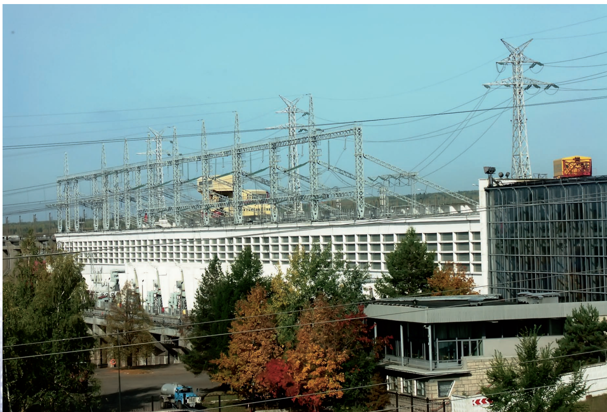
Воткинский гидроузел. Общий вид ГЭС
