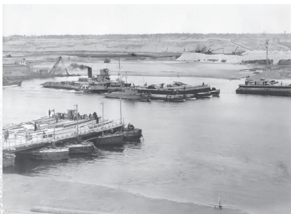
Наводка секций наплавного моста для перекрытия Камы
