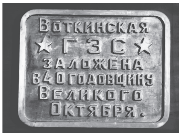
Бронзовая плита, уложенная в основание ГЭС 4 ноября 1957 года
