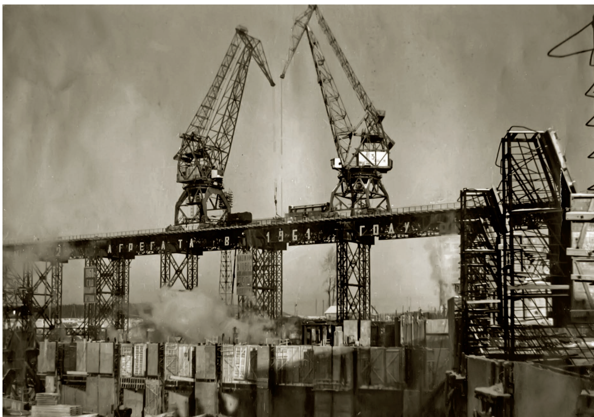
Воткинский гидроузел. Лозунг о принятом обязательстве по досрочному пуску ГЭС
