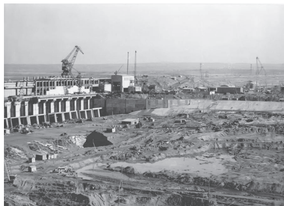
Подготовка котлована ГЭС к затоплению
