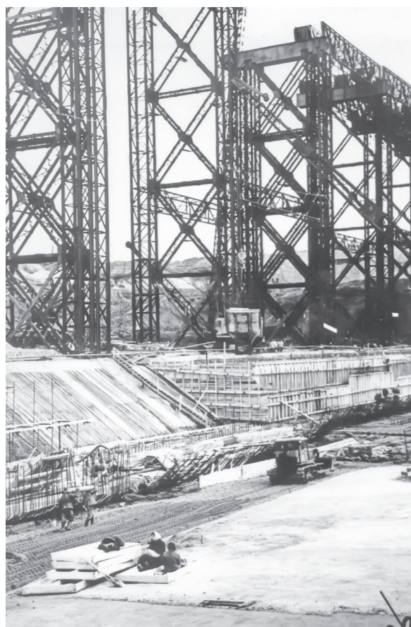
Монтаж бетоновозной эстакады высотой 40 м для сооружения ГЭС
