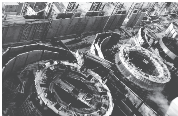
Насыщенность арматуры и армопанелей под укладку бетона
