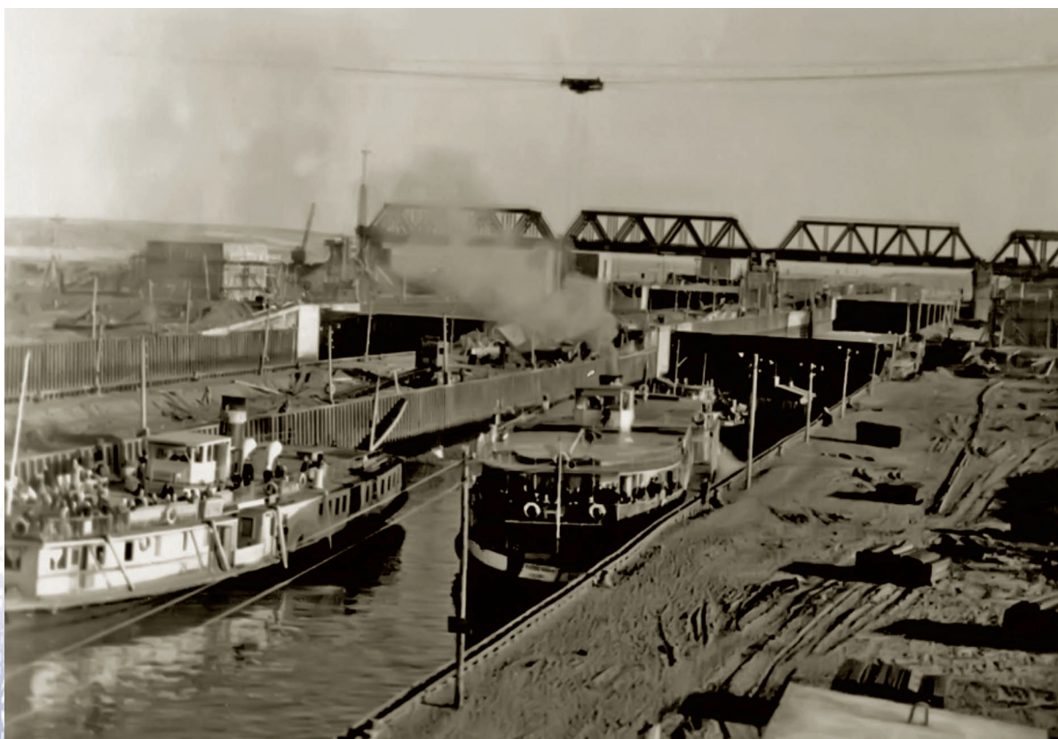
Шлюзование судов на судоходном Камском шлюзе, 1954 год
