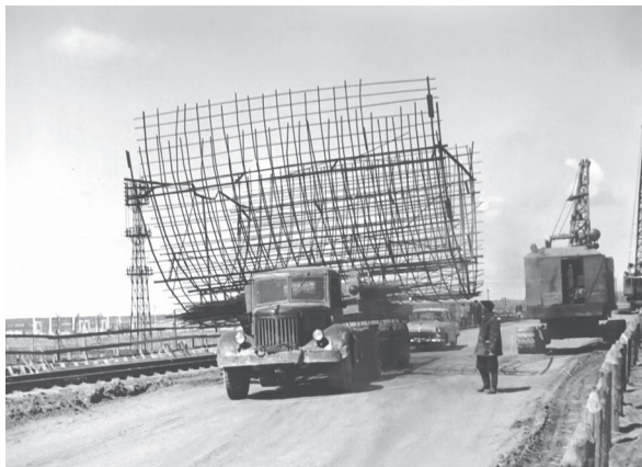
Доставка арматурных блоков к месту монтажа
