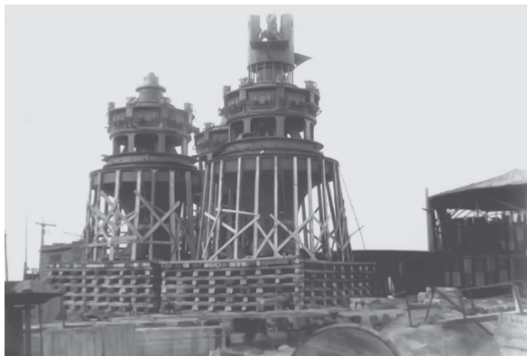
Камская ГЭС. Подготовленные к монтажу гидротурбины, 1955 год
