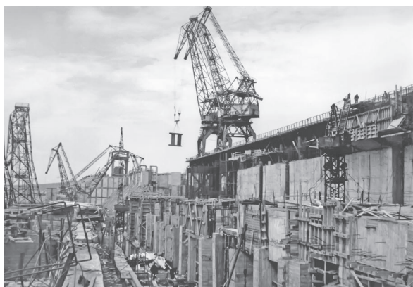
Спаренная работа порталных кранов при монтаже гидросилового оборудования
