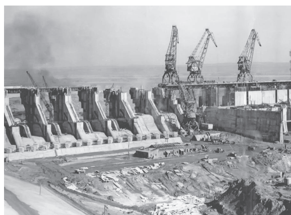
Очистка котлована ГЭС перед затоплением
