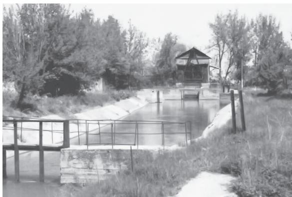
ГЭС-6. Напорный бассейн
