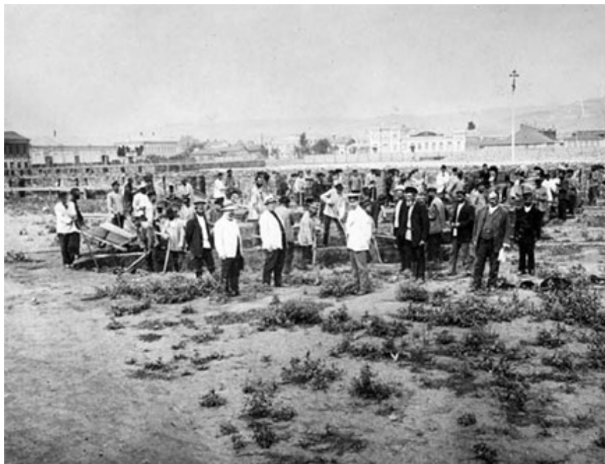
Начало земляных работ при строительстве университетских зданий на Московской площади. Фото 25 июня 1910 года.
