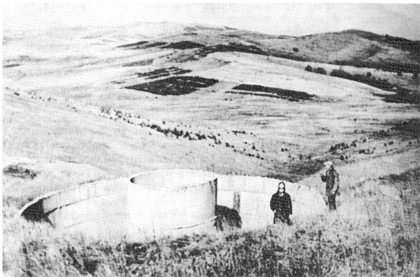
**Рис. 20. Опорный стакан под Крымскую ветроэлектростанцию, установленный в 1937 г. на Ай-Петри (фото 70-х годов Б.И. Романенко)**
