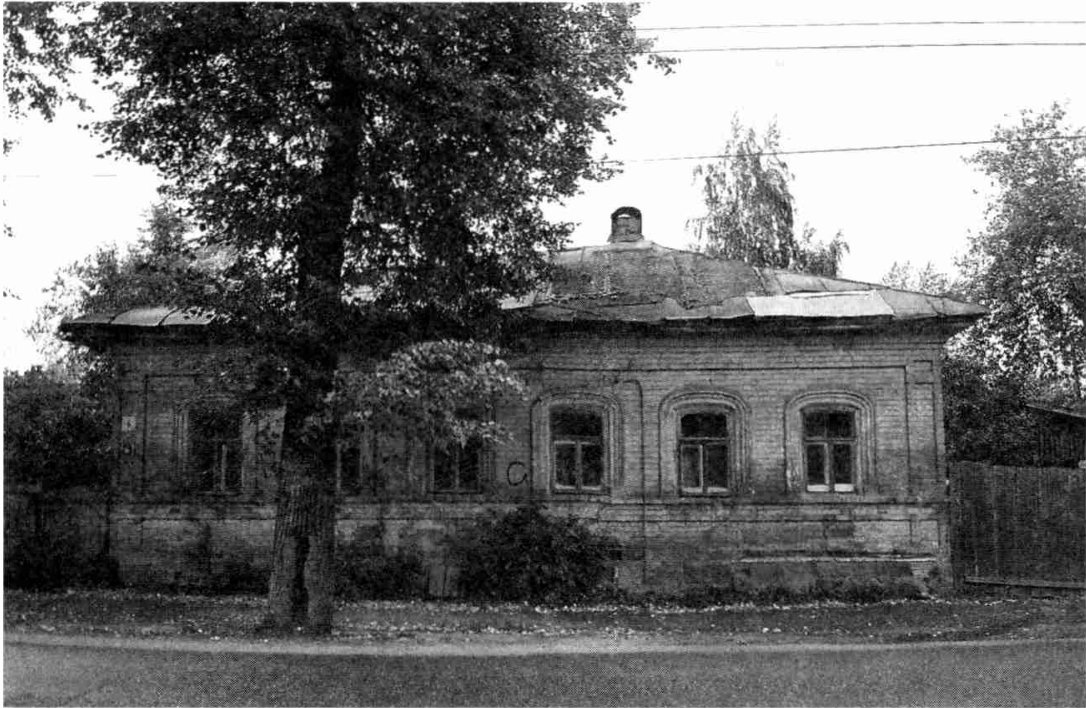
Пермь, дом № 6 по ул. Большевистской, где в 1920-х – начале 1930-х гг. снимал квартиру профессор В. П. Первушин. Фото 2008 г.
