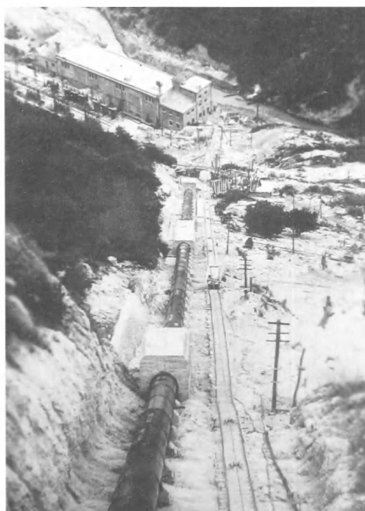
На строительстве Гизельдонской ГЭС
