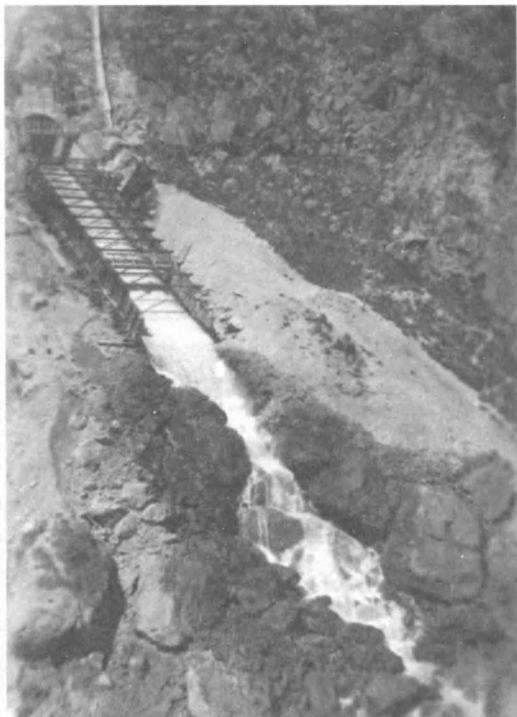
Строительство Гизельдонской ГЭС, 1932 г.
