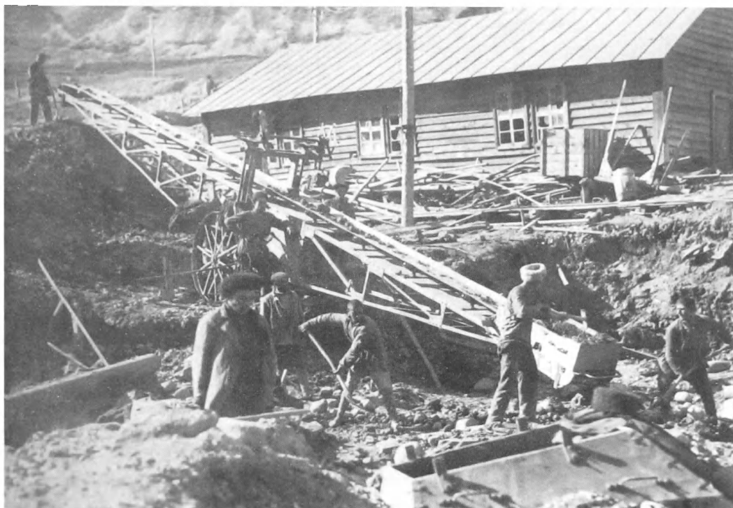
На строительстве Гизельдонской ГЭС
