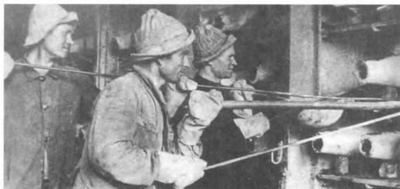
Ударников завода Севкавцинк всегда отличал особый настрой
