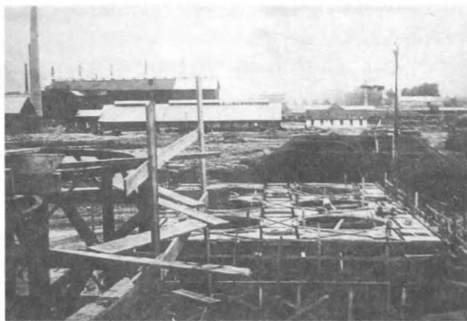
Строительство нового литейного цеха на заводе Севкавцинк
