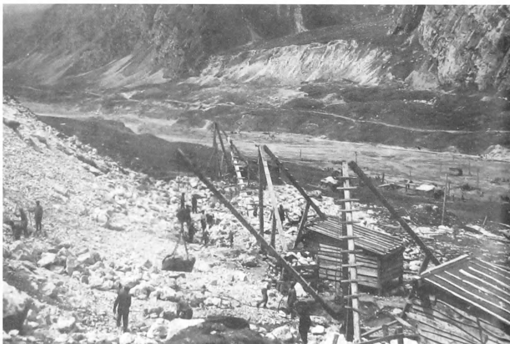
На строительстве Гизельдонской ГЭС
