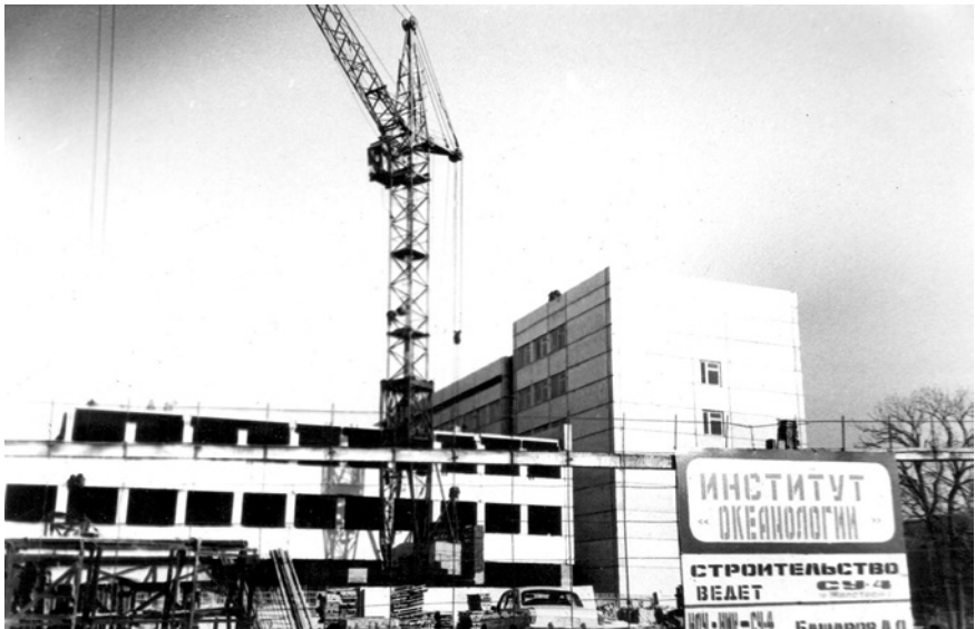
Строительство здания ТОИ
