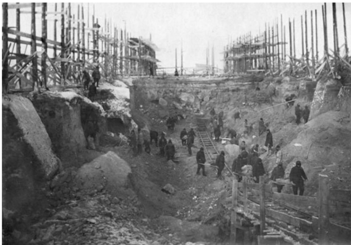
07.04. Начало строительства атомного реактора «А-1». 61
