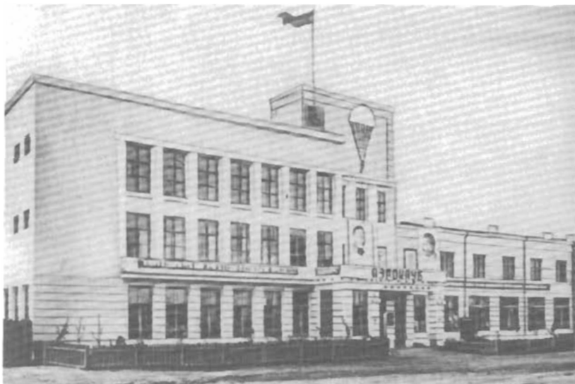
Новосибирск, 30-е годы. Здание аэроклуба
