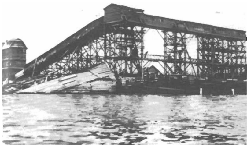
Транспортная галерея-эстакада, связавшая хлебоприемный пункт с разгружающимися на пристани Камня-на-Оби баржами с хлебом. Построена по проекту Ю. В. Кондратюка
