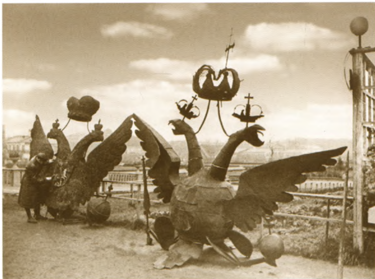
Демонтаж двуглавых орлов на кремлёвских башнях. 1935 г.
