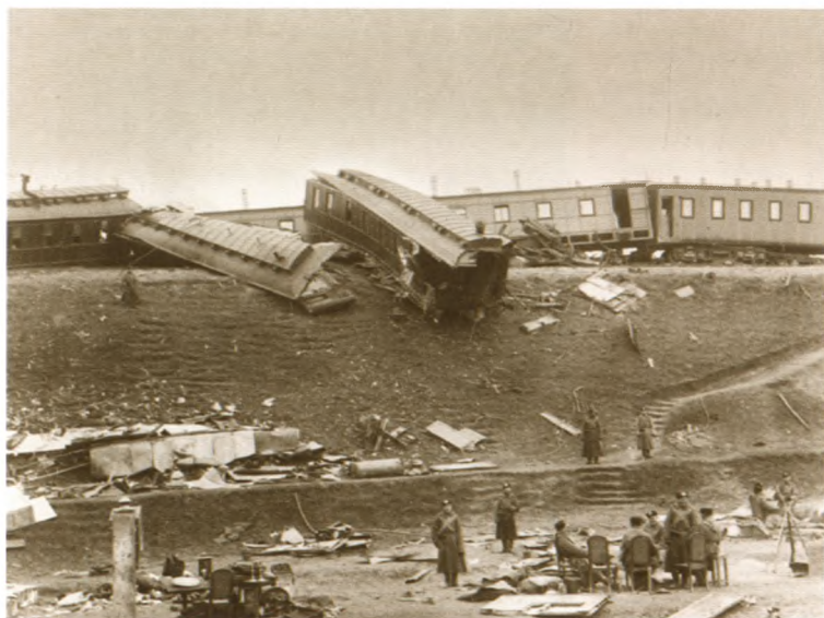
Крушение царского поезда. 18 октября 1888 г.
