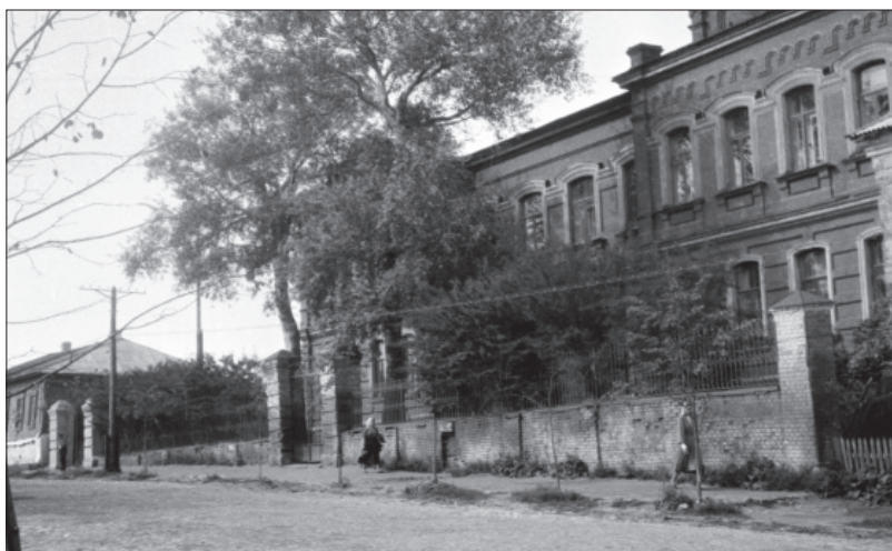
Здание бывшего духовного училища в Скопине, 1954 г. Фото Д.И. Журавлева
