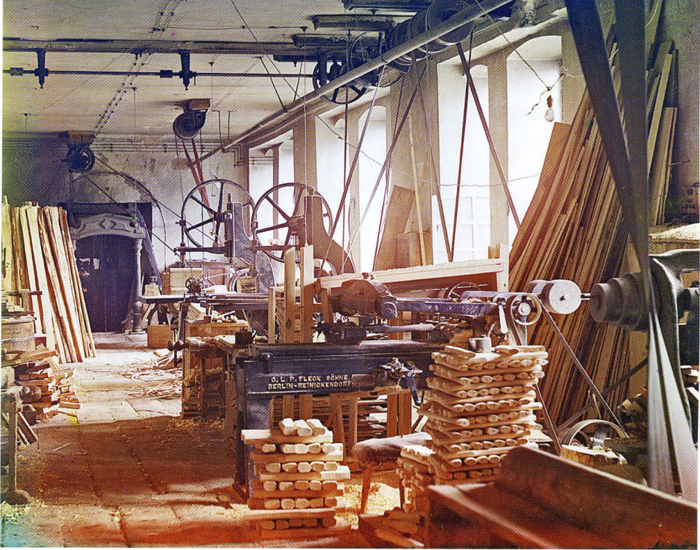
▲ Столярный цех для выделки ножен при Златоустовском заводе. Отдел коллекции «Урал».
