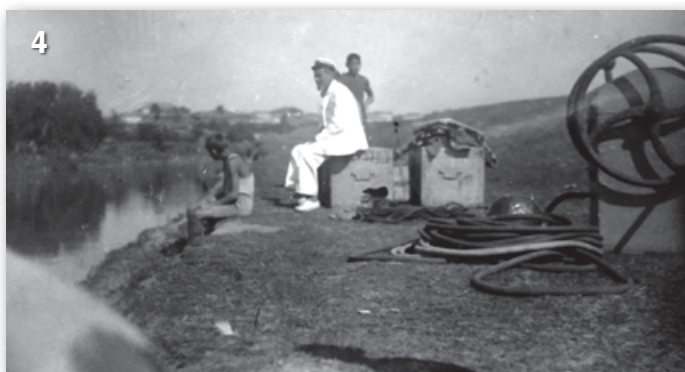
1-4: Работы на Южном Буге
