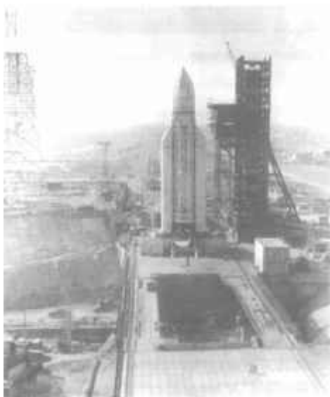
Первый вывоз ракеты-носителя «Энергия» 4М на УКСС состоялся до завершения строительных работ
