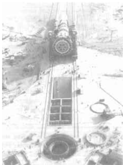
Комплекс Н1-ЛЗ около пускового устройства
