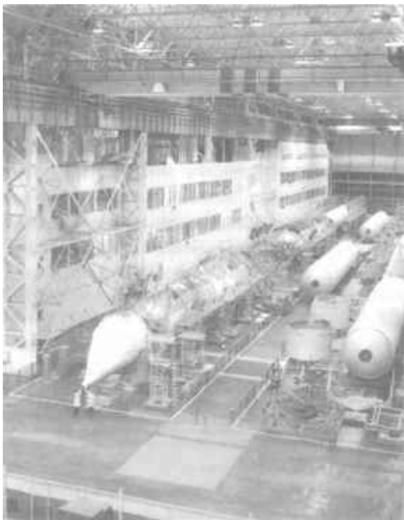
Монтажно-испытательный корпус ракеты-носителя «Энергия». Пролет сборки блоков первой ступени
