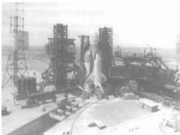
Установка системы «Энергия-Буран» на стартовый комплекс
