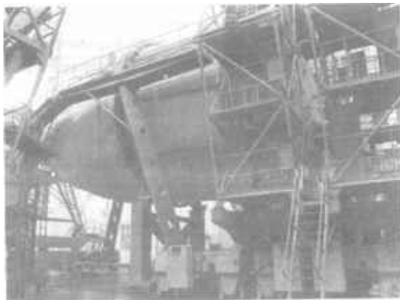
Бак окислителя второй ступени ракеты-носителя «Энергия» в монтажно-стыковочном стенде, обеспечивающем сборку верхнего полублока
