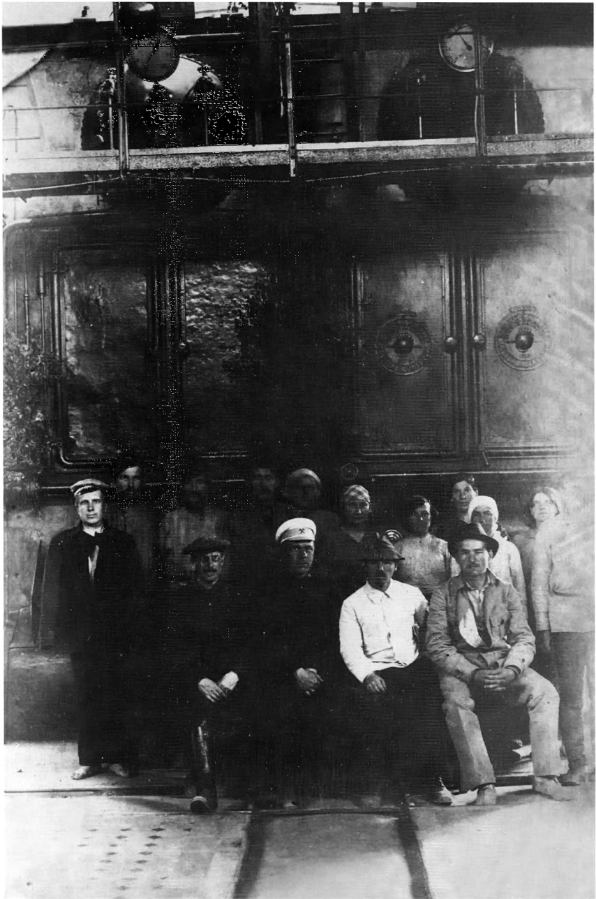
Топка центральной котельной с конвейерной подачей твёрдого топлива на Тамбовском пороховом заводе, усовершенствованная П.В. Можаровым (1924 г.)
