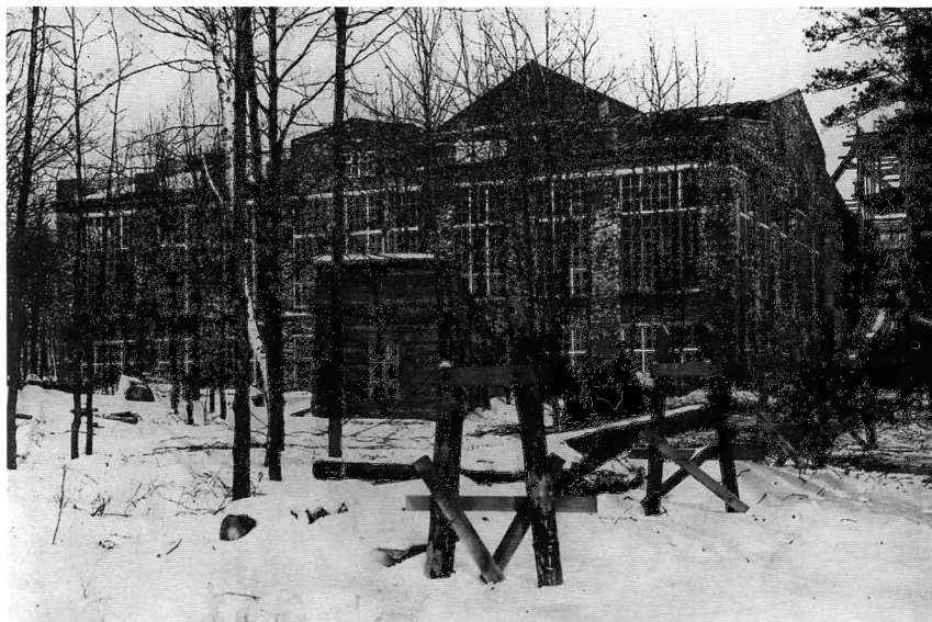
Строящийся корпус одного из цехов Тамбовского порохового завода (1915 г.)
