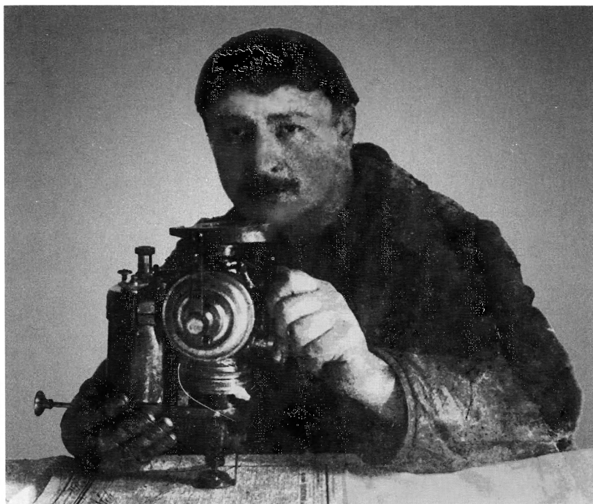
Пётр Можаров регулирует карбюратор двигателя Anzani (1914 г.)
