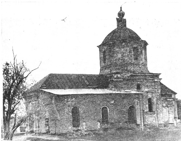
Церковь в селе Спасском, построенная в 1764 г. П. И. Рычковым. Современный вид
