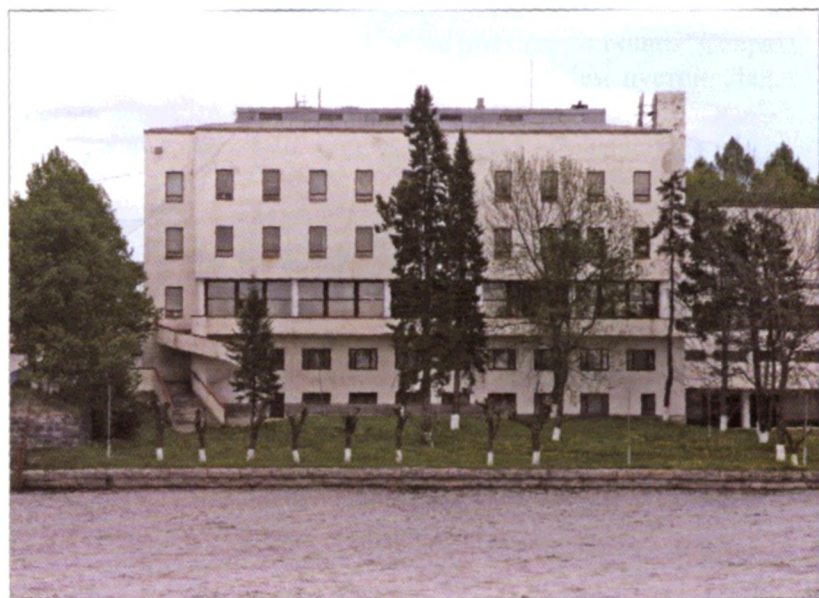
Современный вид гостиницы «Сеурахуоне». Фото 2009
