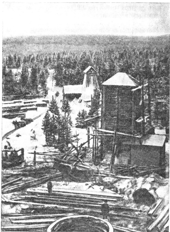
Строительство Соликамского калийного рудника (1927)
