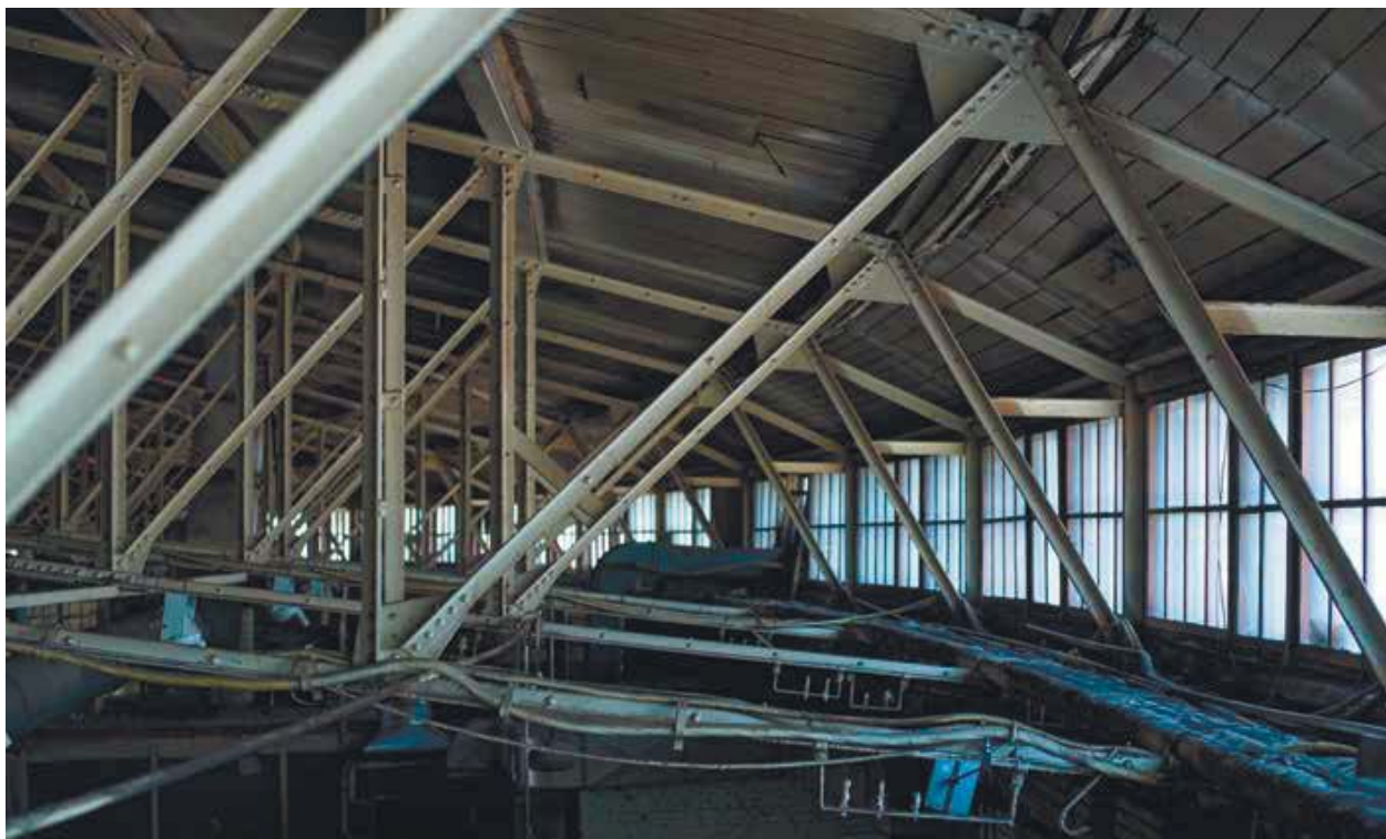
Металлические перекрытия гаража
