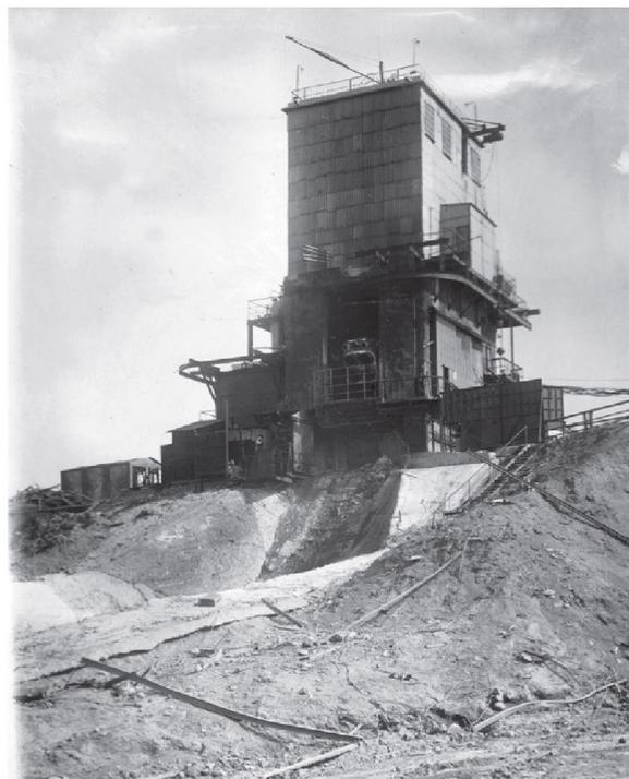
Стенд для огневых испытаний РД-107 в ОКБ-456
