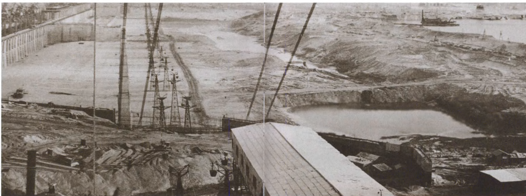
Начальный период строительства Сталинградской ГЭС
