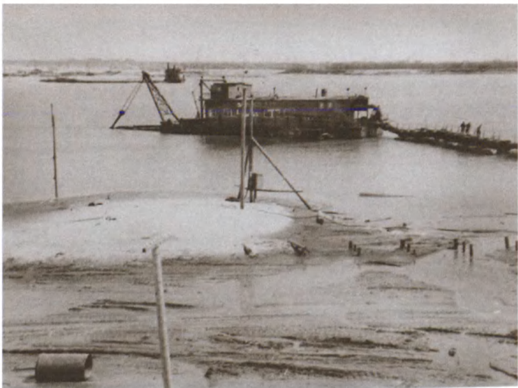
Земснаряды на намыве перемычек и осушении котлована ГЭС
