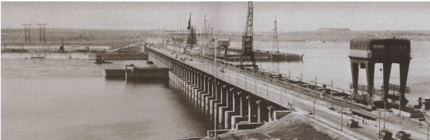
Сталинградская ГЭС перед сдачей в эксплуатацию
