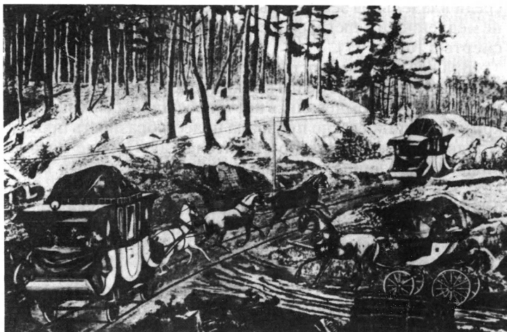
Первая конная железная дорога Будвейс—Линц.
