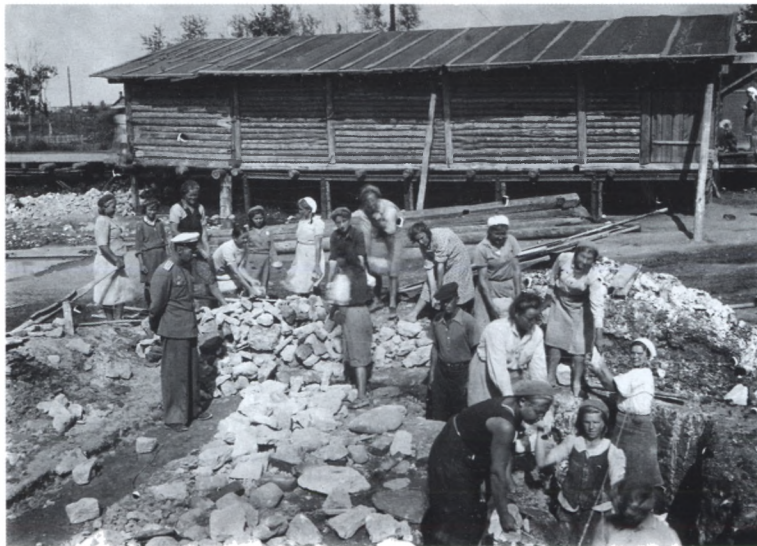
При восстановлении вокзала, станция «Чудов». 1945 г.
