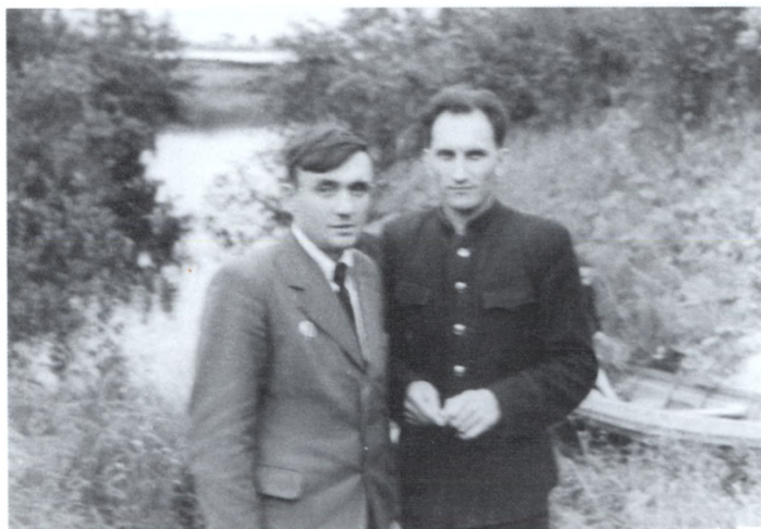
Михаил Николаевич с военным другом при строительстве моста в Шлиссельбурге. 1950 г.
