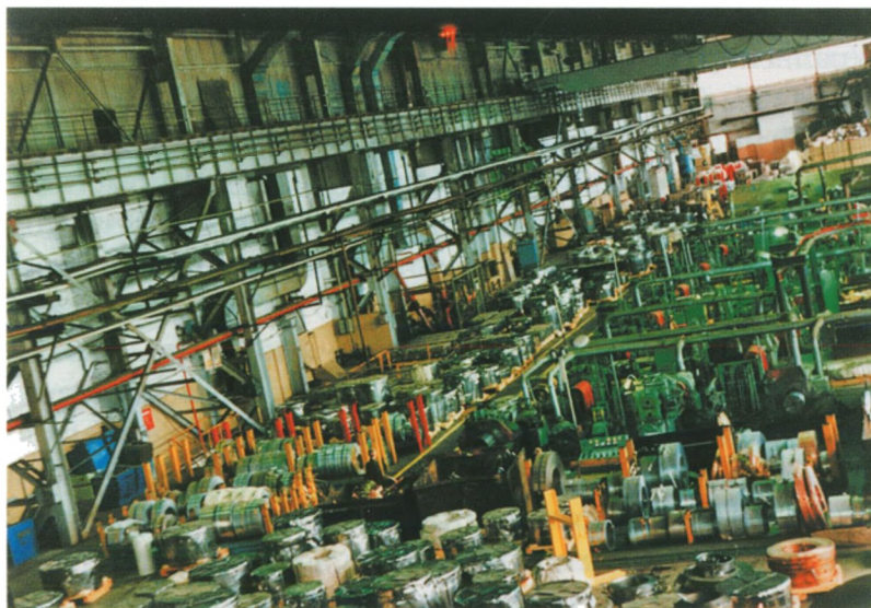
Цех прокатного производства Нытвенского металлургического завода
