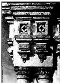
Никольская церковь. Фрагменты фасада
