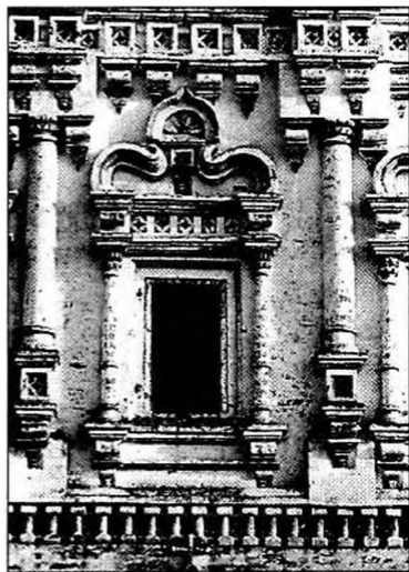
Никольская церковь. Фрагменты фасада
