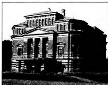
Городской театр до реконструкции
