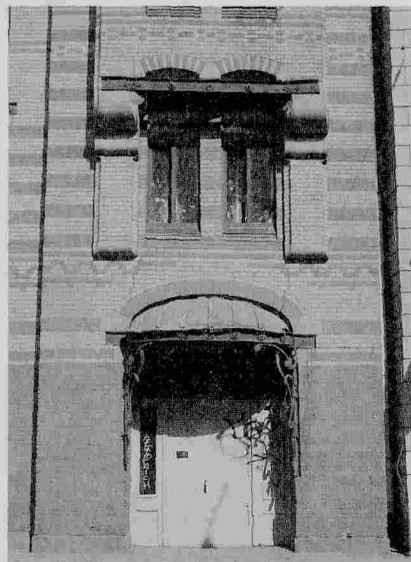
Доходный дом Г. А. Шульце. Фрагменты фасада
