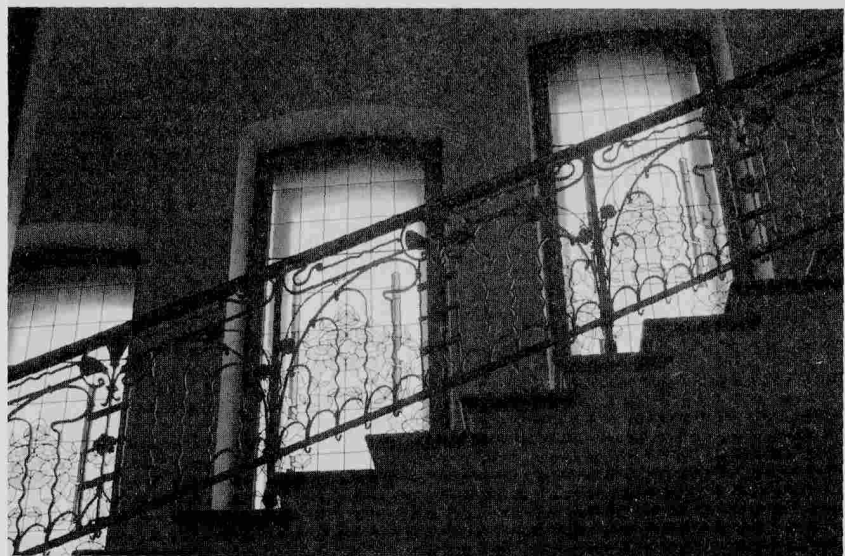
Здание фирмы К. Г. Фаберже. Парадная лестница
