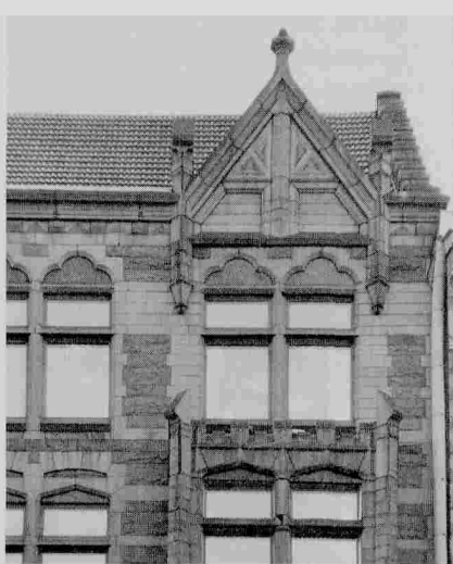
Здание фирмы К. Г. Фаберже. Детали фасада
