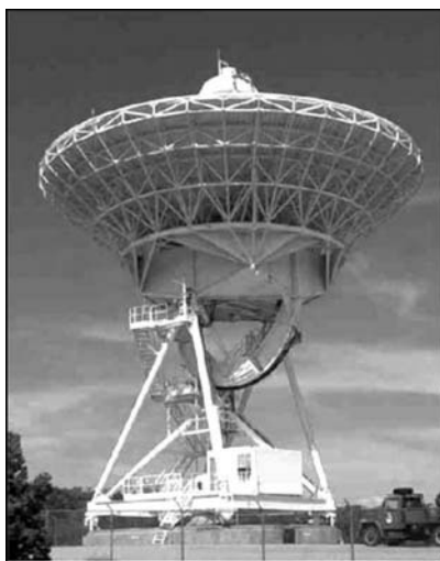
Рис. 2.18. Крупнейший современный радиотелескоп VLA (Very Large Array), Соккоро, юг США (вверху). Справа отдельный составляющий элемент телескопа — зеркало диаметром 25 м
