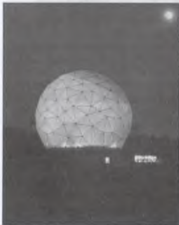
Рис. 3.38. Купол, используемый для 14-м антенны в радиоастрономической обсерватории ECRAO (США)
