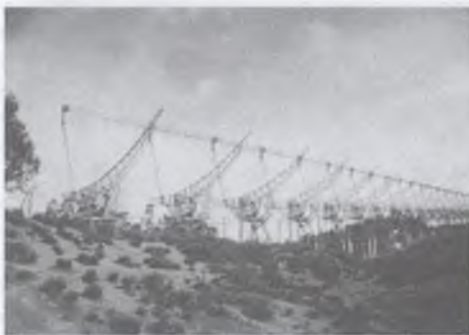
Рис. 3.23. Радиотелескоп формы цилиндрического параболоида в Индии
