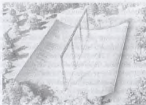
Рис. 3.20. 100-м параболический рефлектор с внеосевым облучателем в Грин-Бэнк (США)
