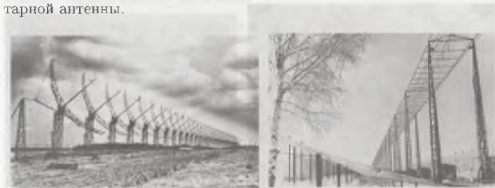
Рис. 6.24. Радиотелескоп типа креста Миллса в Пуццо (Россия)
