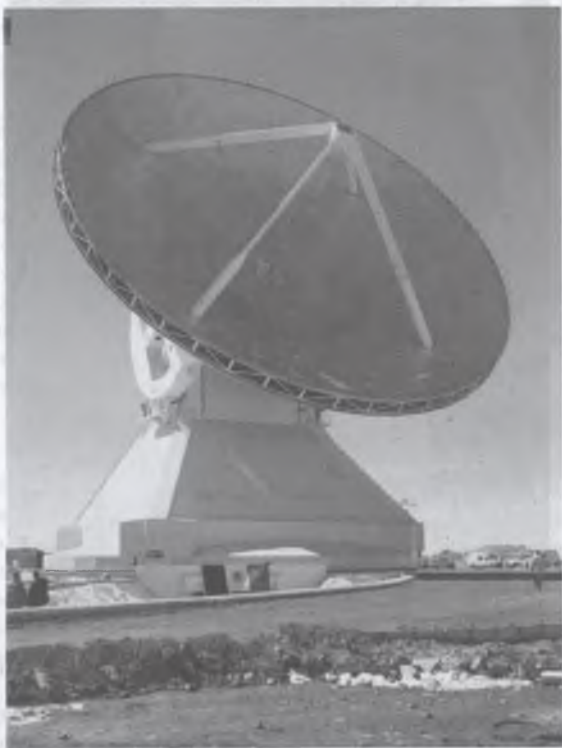
Рис. 3.19. Крупнейший в мире полноповоротный параболический радиотелескоп диапазона 1–4 мм (Сьерра Негра, Мексика)
