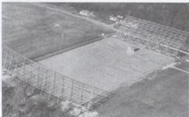
Рис. 3.24. Антенна системы Крауса в Огайо (США)
