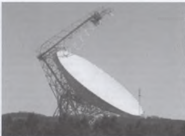
Рис. 3.20. 100-м параболический рефлектор с внеосевым облучателем в Грин-Бэнк (США)
