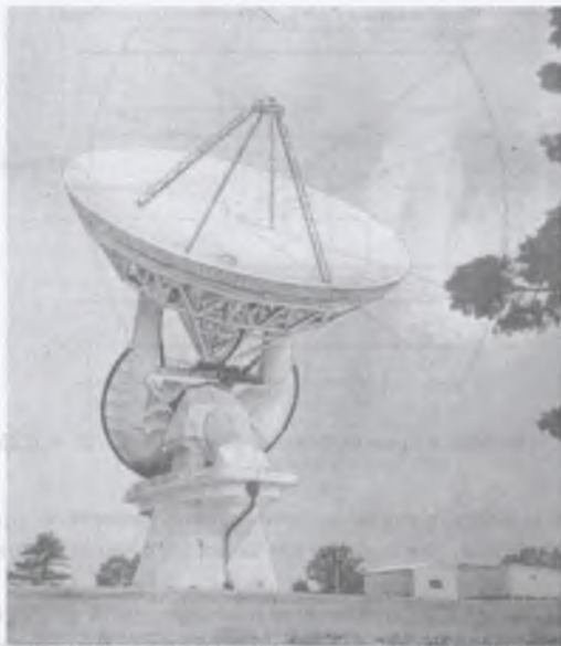
Рис. 3.13. 43-м радиотелескоп с параболическим рефлектором на экваториальной установке (Грин Бэнк, США, 1965 г.)
