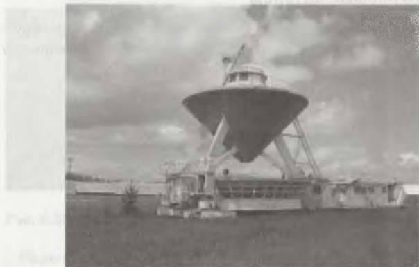
Рис. 6.27. Облучатель радиотелескопа РАТАН-600 для режима использования всего кольца
