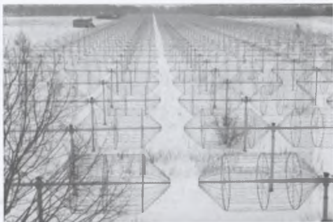
Рис. 3.33. Т-образная фазлируемая решетка декаметрового диапазона УТР-2
