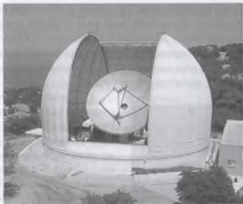
Рис. 3.37. Защитный купол (аналог оптического) для 12-м антенны мм-диапазона в Кит Пик (США)
