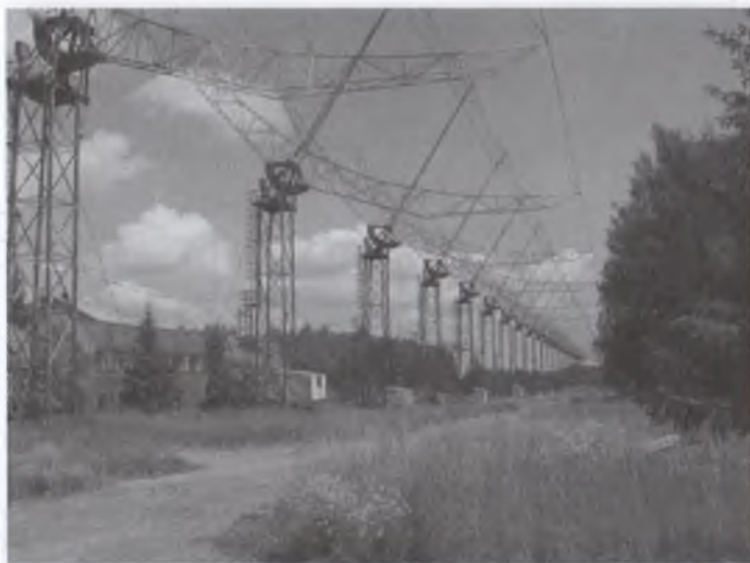
Рис. 3.22. Радиотелескоп ДКР-1000 в ПРАО (Россия)
