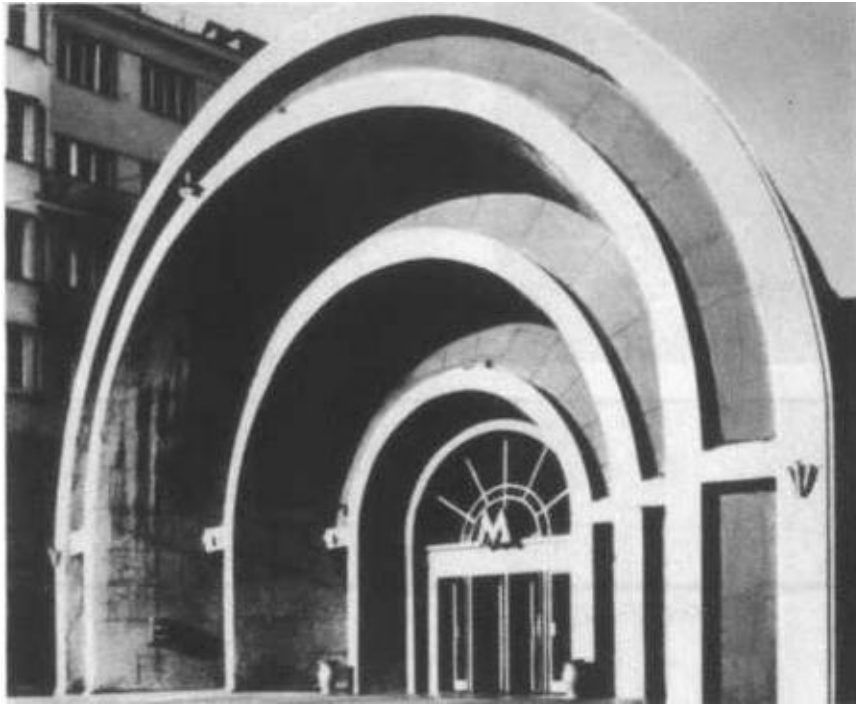
Станция метро «Красные ворота». Наземный павильон. 1935
