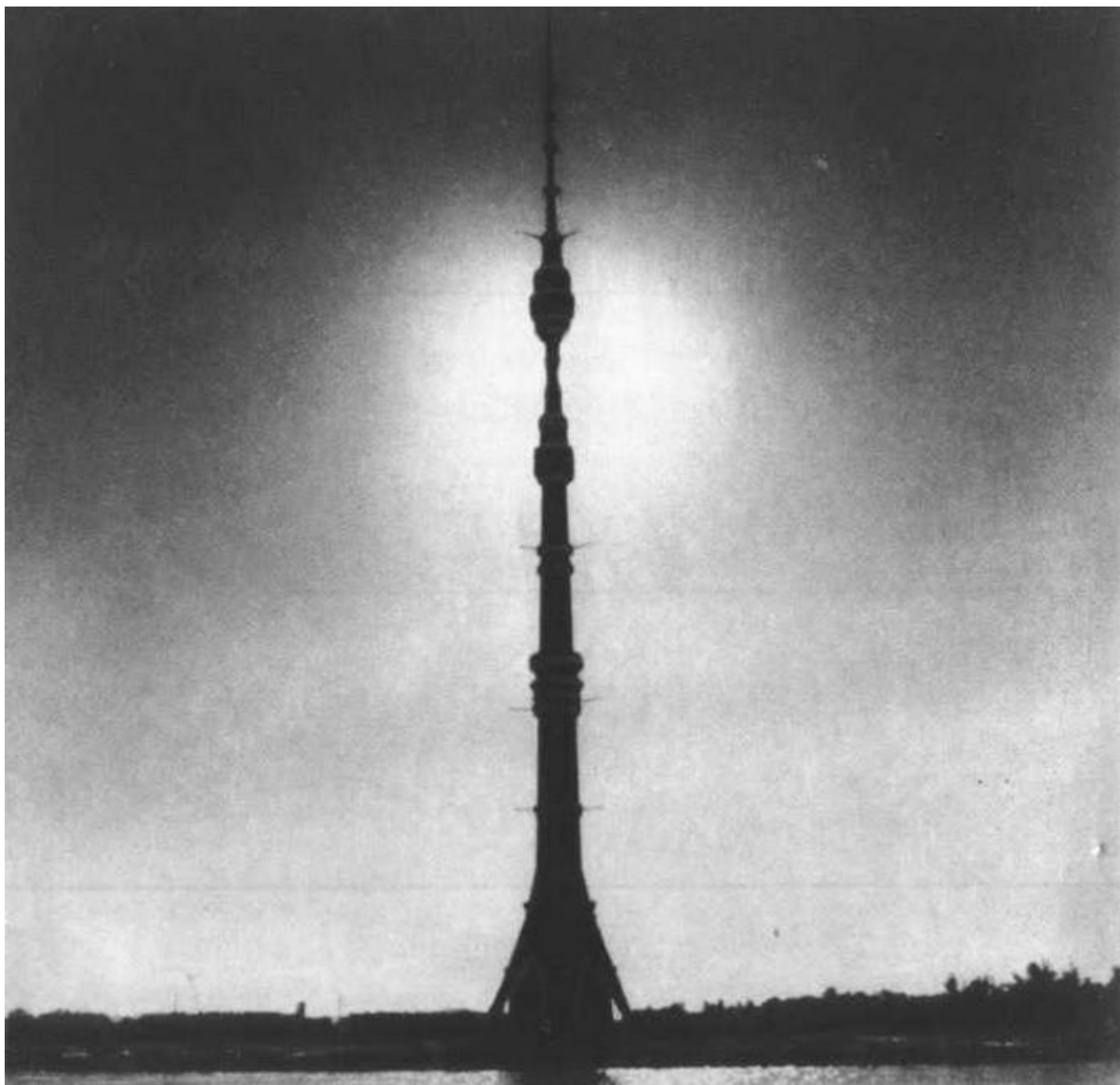
Телевизионная башня в Останкине. 1967. Инженеры Н. Никитин, Б. Злобин, совместно с Л. Баталовым, В. Милашевским
