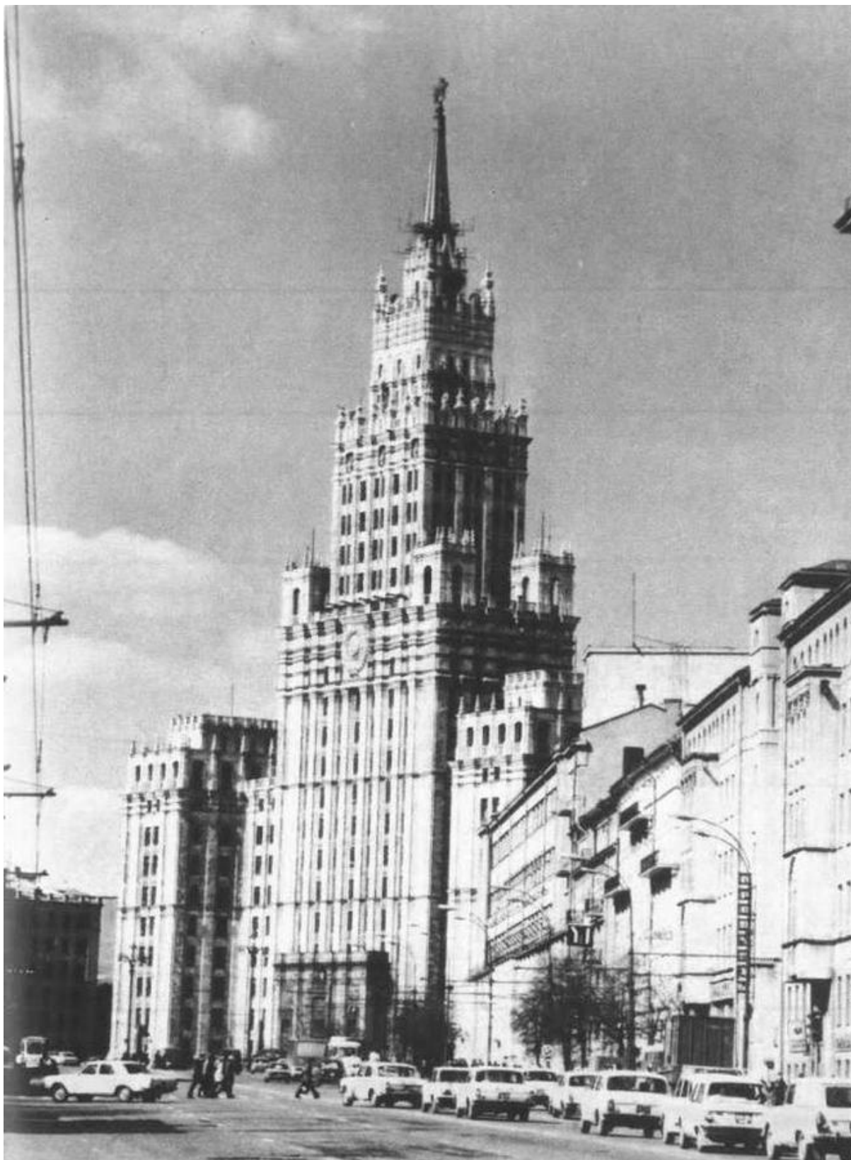
Административное и жилое здание на Лермонтовской площади.
