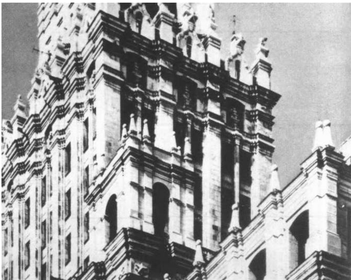
Административное и жилое здание на Лермонтовской площади. Фрагменты. 1949—1953. Совместно с А. Душкиным, инженер В. Абрамов
