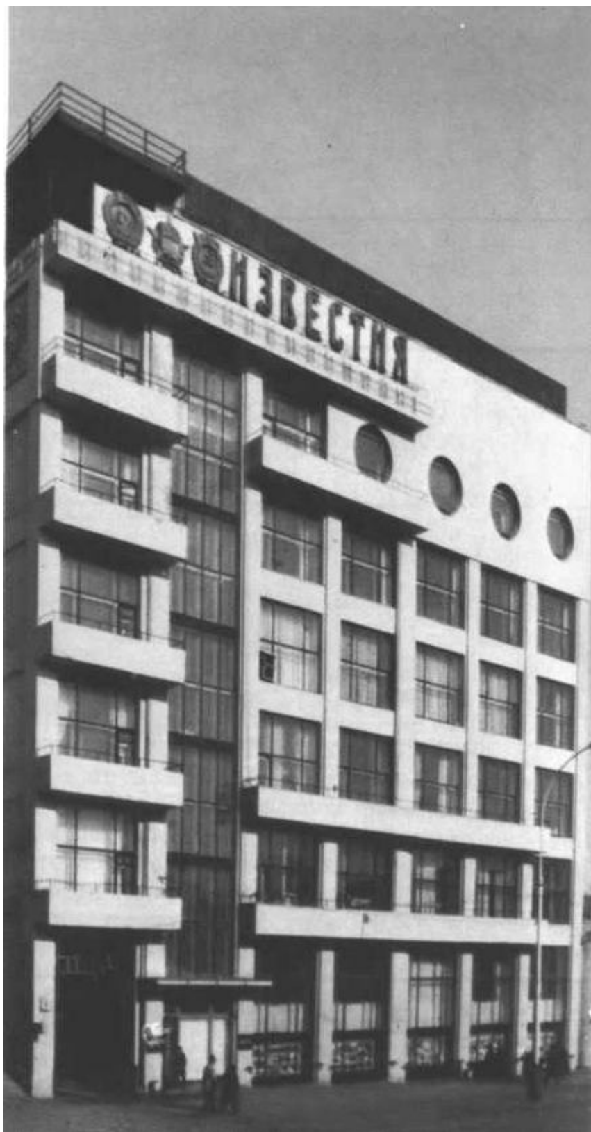
Здание газеты «Известия». /1927. Конструкция А. Лолейта
