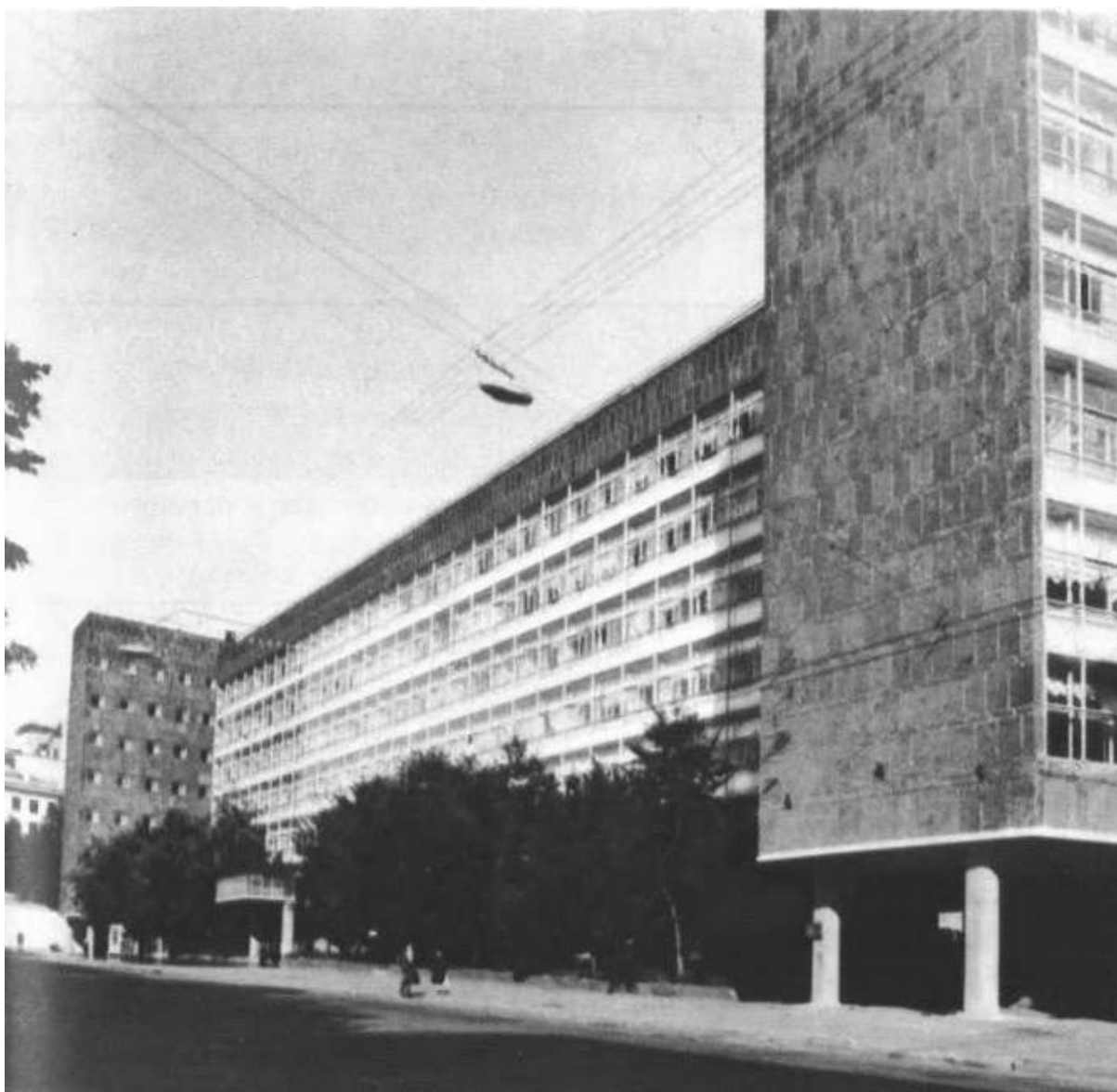
Здание Центросоюза (ныне ЦСУ СССР) на улице Кирова. Участие в работе Ле Корбюзье
