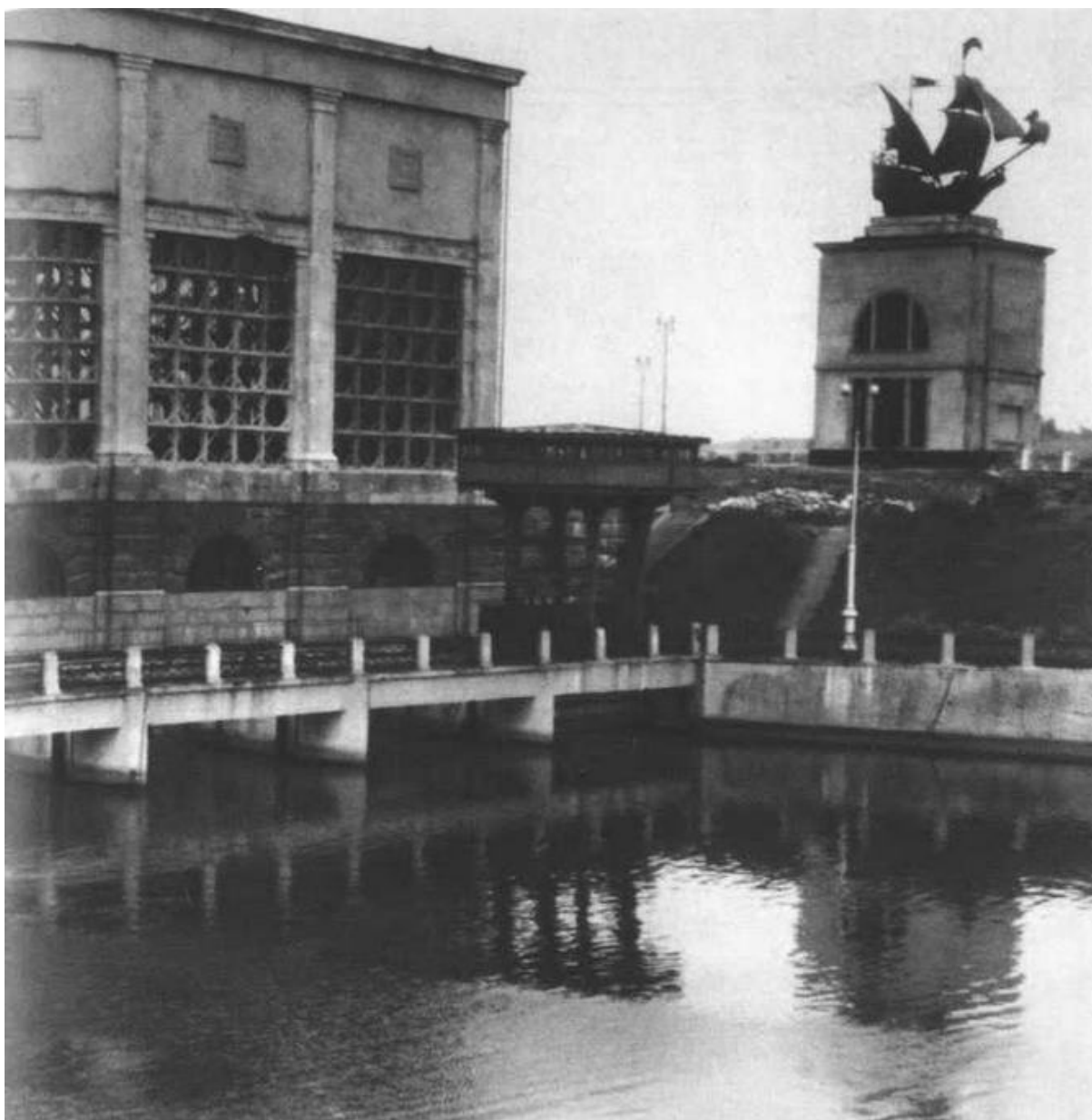
Башня управления шлюза на канале имени Москвы. — 1937. Совместно с И. Мовчипом. Л. Рухлядевым, Д. Савицким. инженер Л. Бачелис
