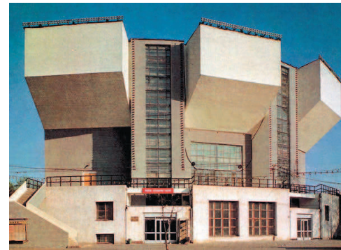
Клуб им. Русакова — здание построено архитектором К.С. Мельниковым в 1927–1929 гг. в Москве
