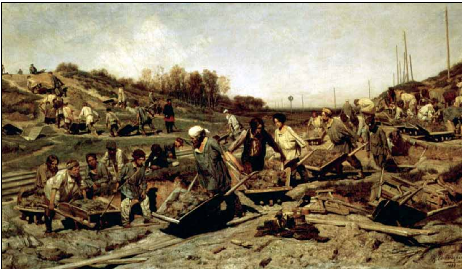
К. А. Савицкий. Ремонтные работы на железной дороге. 1874
