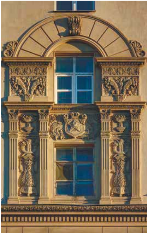
Фасадный лепной портал
