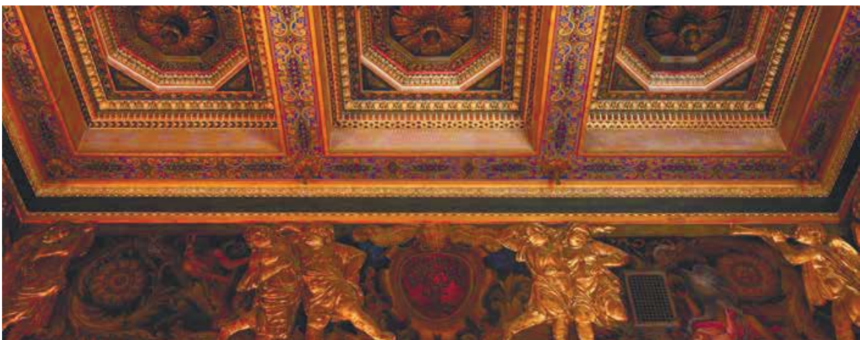
Кессонный потолок и фриз в кабинете в части особняка Г. Г. Тарасова
