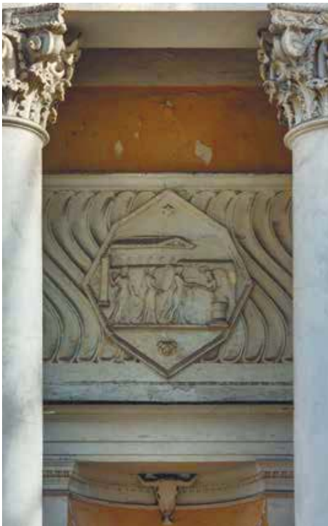
Рельеф между колонн портика входа со стороны Скаковой аллеи
