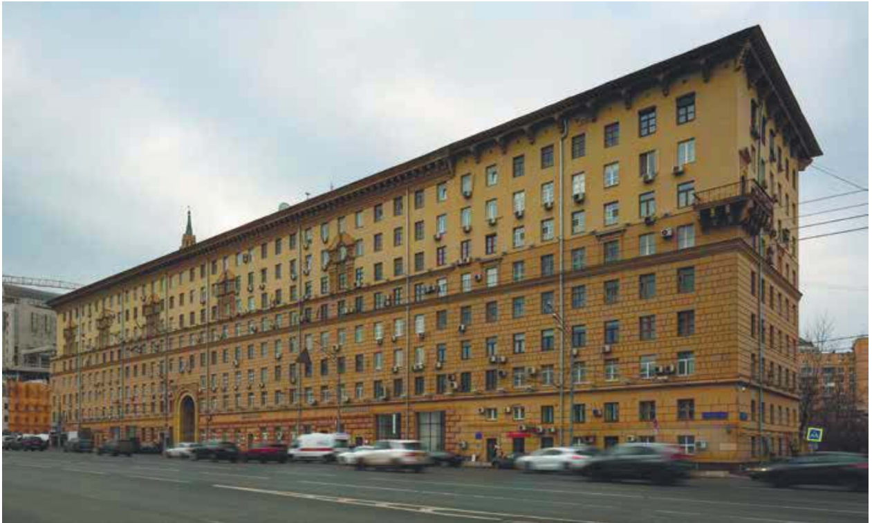
Общий вид жилого дома для сотрудников НКВД с правой стороны
