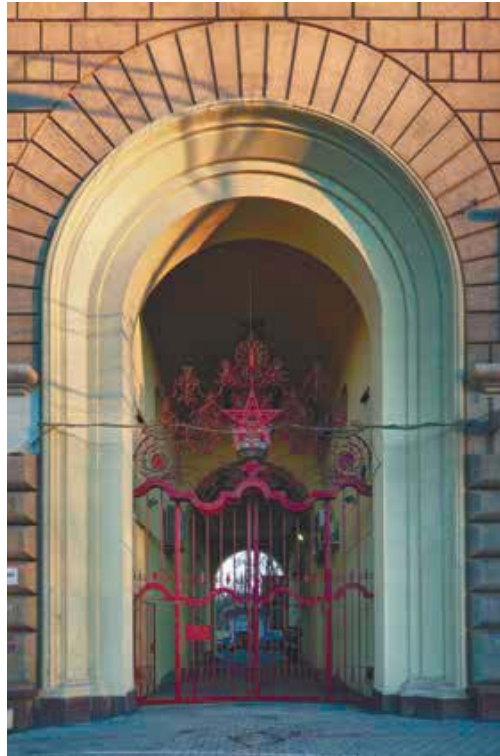
Арка проезда во двор дома на ул. Б. Калужская
