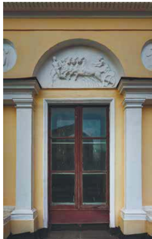
Отделка окна второго этажа, выходящего на балкон над боковым входом
