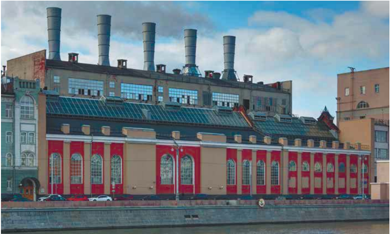
Котельная МОГЭС. Вид со стороны реки. Москва, Россия
