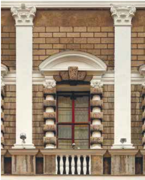
Фрагмент фасада второго этажа особняка Г. А. Тарасова
