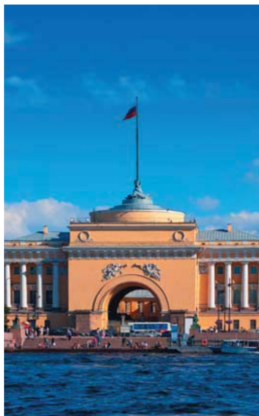
Главный фасад северо-восточного павильона Адмиралтейства. Вид со стороны реки Невы
