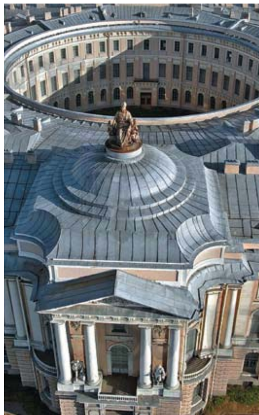
Академия художеств на Университетской набережной Васильевского острова в Санкт-Петербурге. Купол (ремонтные работы и исправление конструкций совместно с А. Н. Ворониным)
