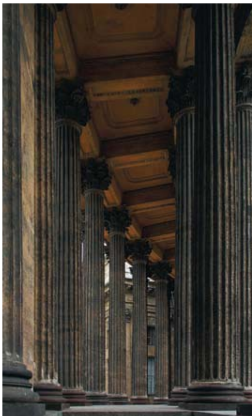
Внутреннее пространство дуговой наружной колоннады
