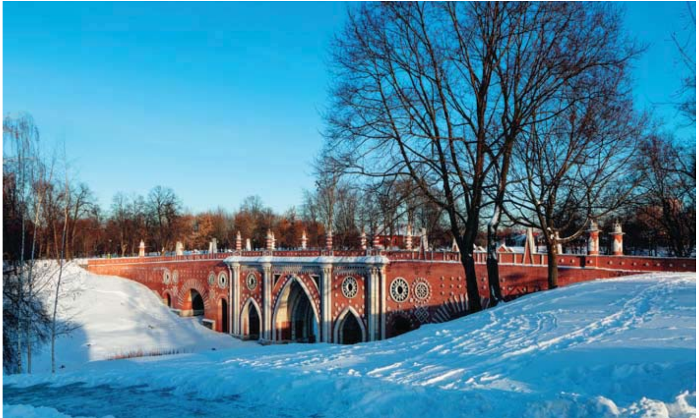
Большой мост над оврагом
