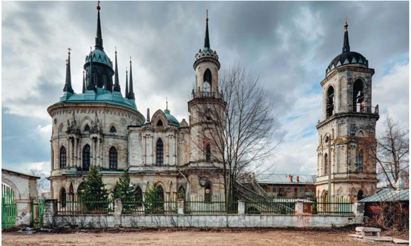
Церковь Владимирской иконы Божией Матери в Быково. Северный фасад
