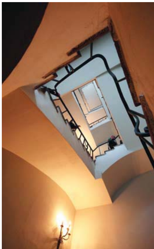
Дом И. И. Юшкова. Домовая лестница со стороны двора
