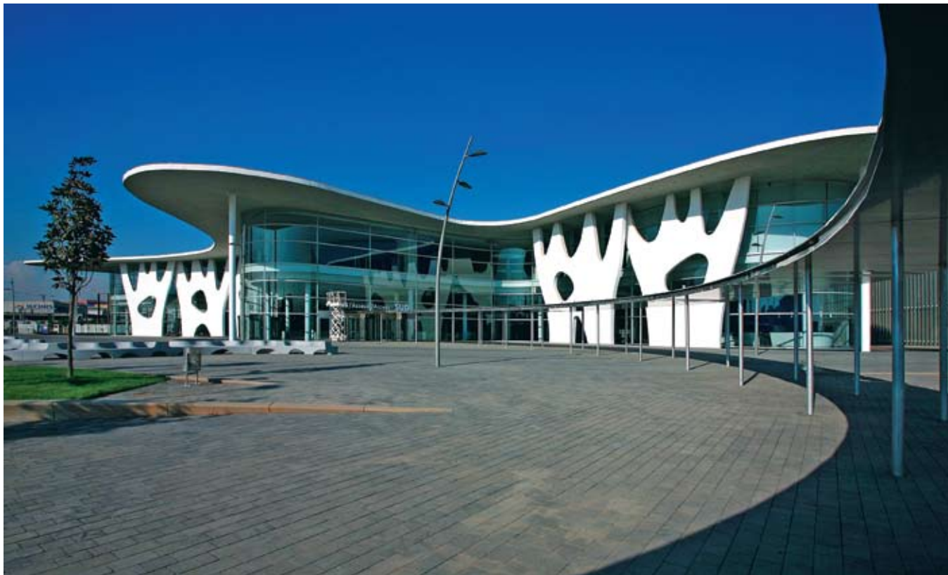
Стилобатная часть, соединяющая две башни
