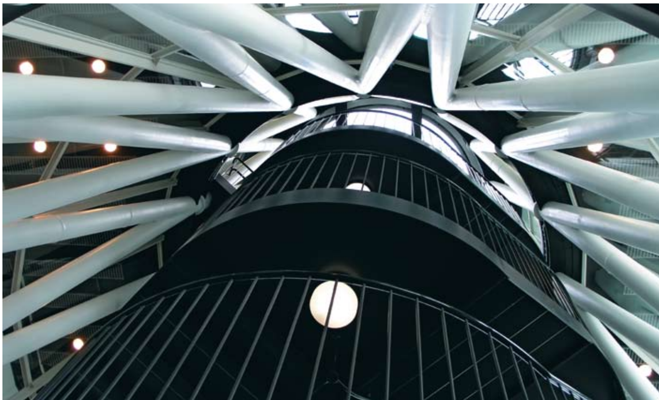
Одна из колонн изнутри
