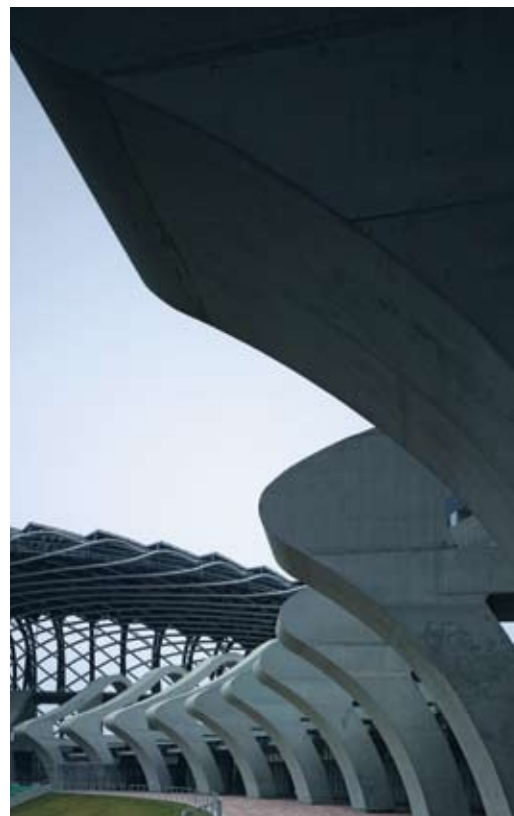
Вид на разомкнутую часть кольца стадиона
