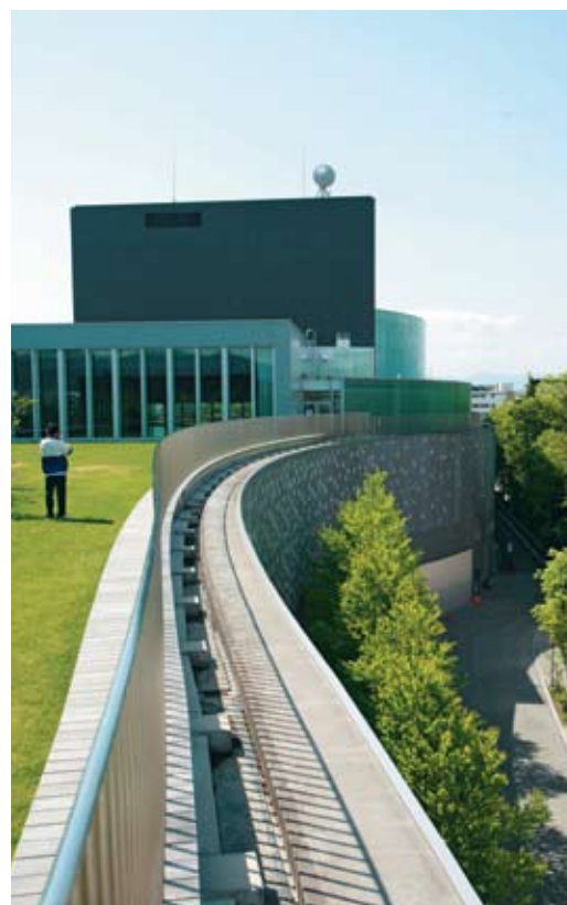
Центр исполнительского искусства. Вид с озелененной крыши
