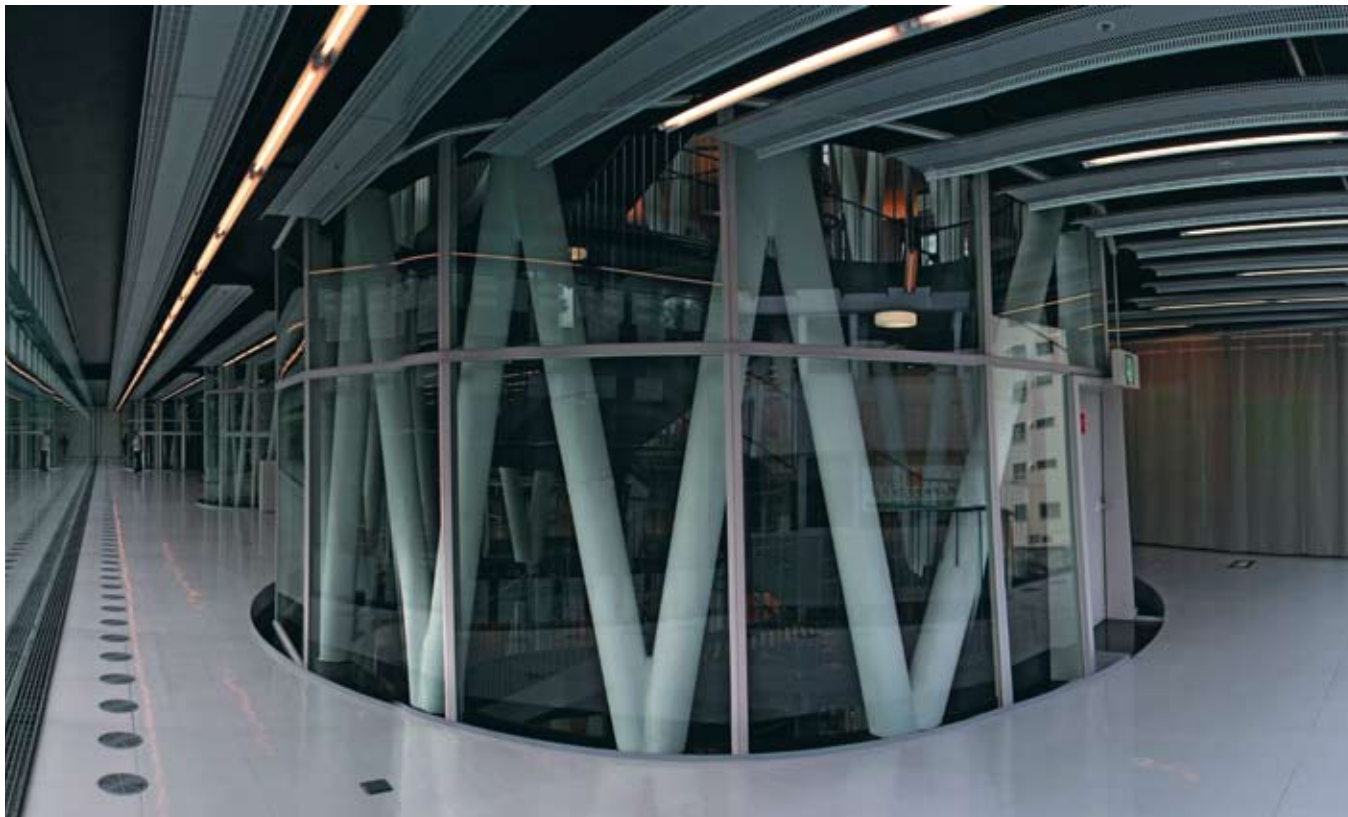
В прямых колоннах — шахты лифтов
