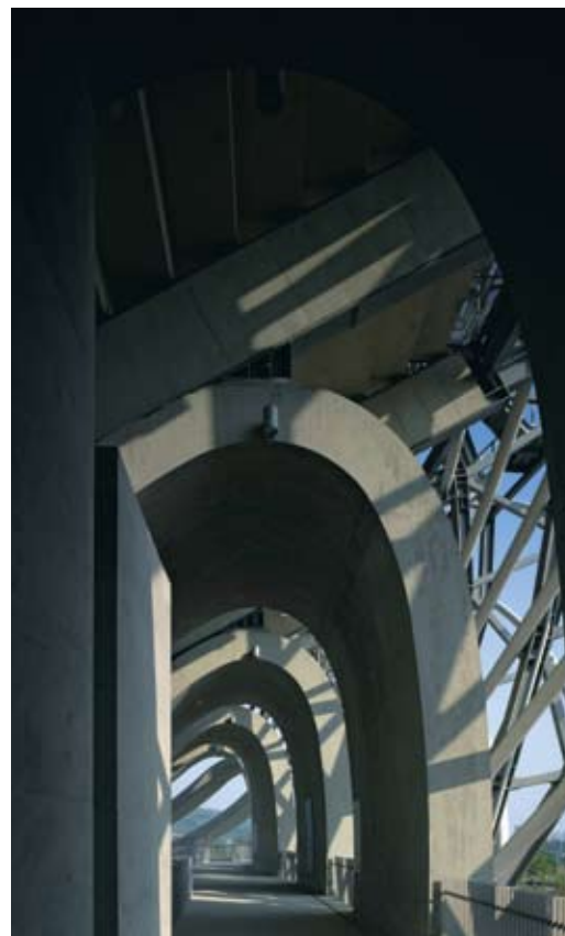
Опорные конструкции стадиона
