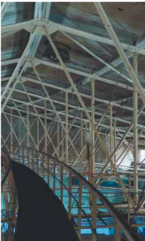
Фрагмент перекрытий гаража на Новорязанской улице
