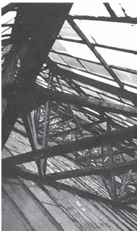
Главпочтамт (арх. О. Р. Мунц, Д. И. Новиков, при участии братьев Весниных). Фермы стеклянного покрытия. Москва, Россия
