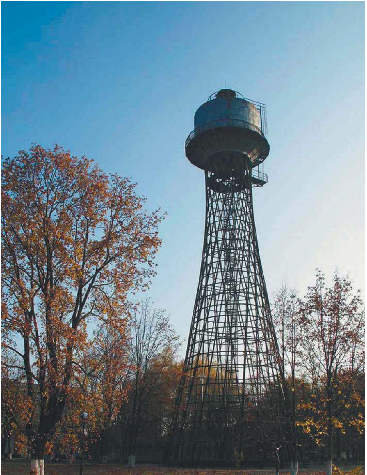
Водонапорная башня. Черкассы, Украина
