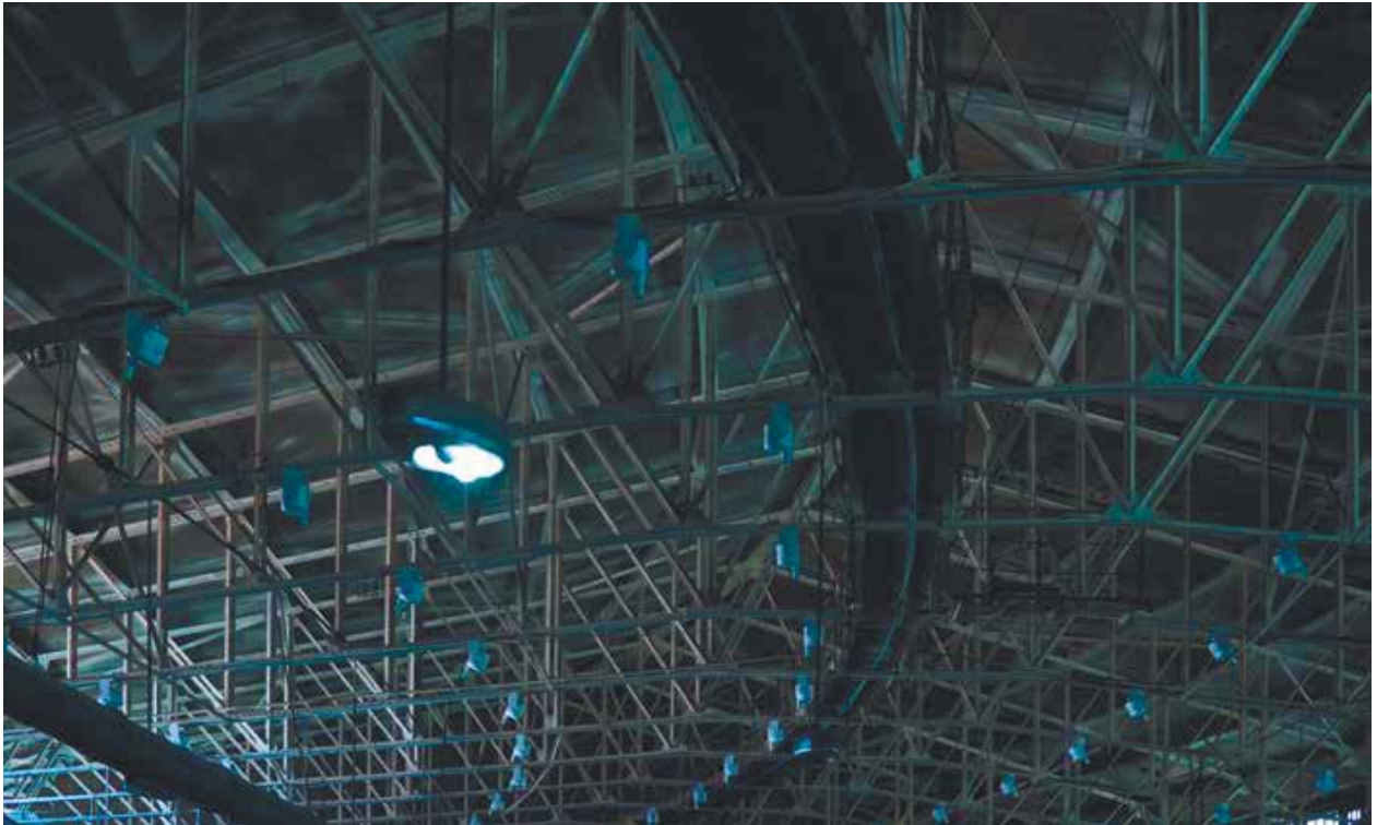
Перекрытия гаража на Новорязанской улице. Москва, Россия
