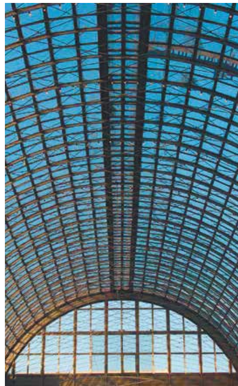
Фрагмент конструкций перекрытия
