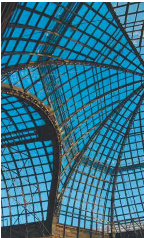
Фрагмент перекрытий центрального купола
