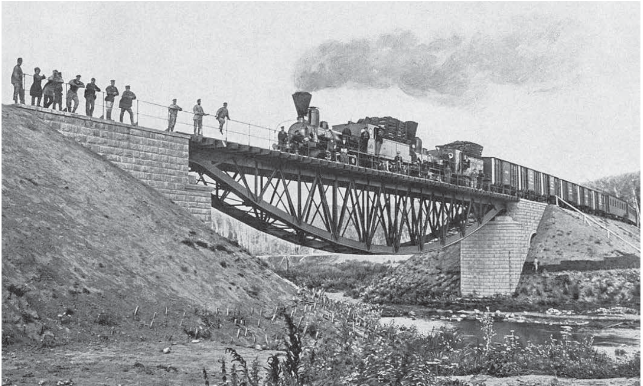
Железнодорожный мост через реку Ушайка. Томская область, Россия
