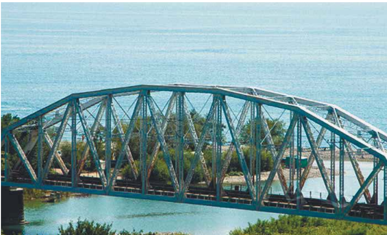
Железнодорожный мост через реку Аше. Краснодарский край, Россия
