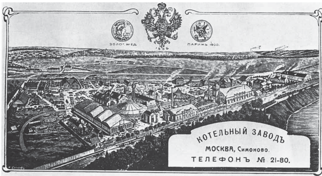
Фрагмент рекламного проспекта фирмы Бари с изображением котельного завода
