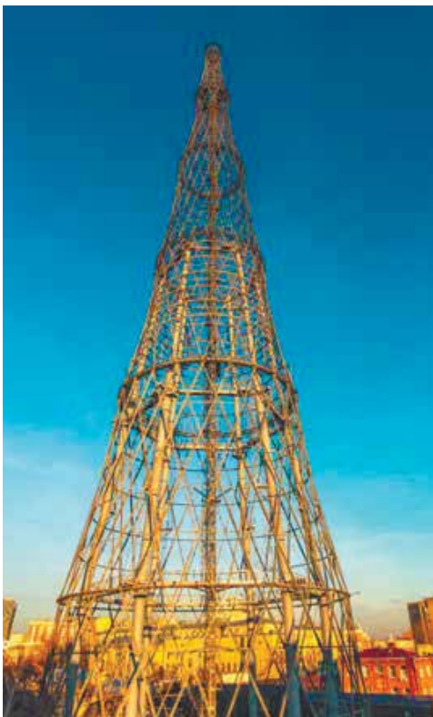
Шестисекционный корпус башни
