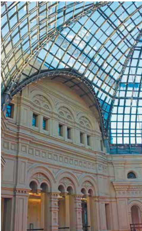
Фрагмент основания центрального купола
