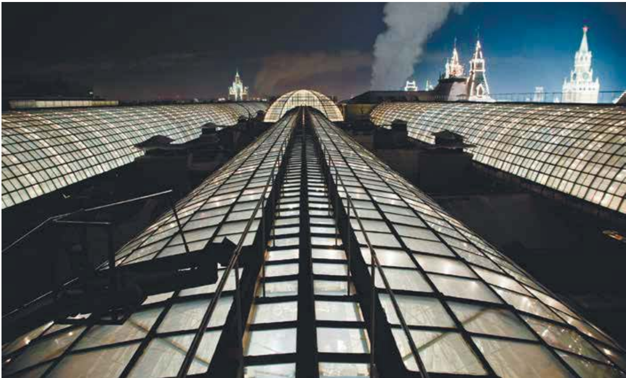
Перекрытия и центральный купол Верхних торговых рядов
