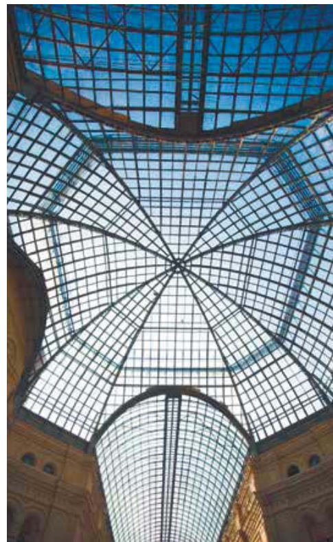
Фрагмент перекрытий с главным куполом
