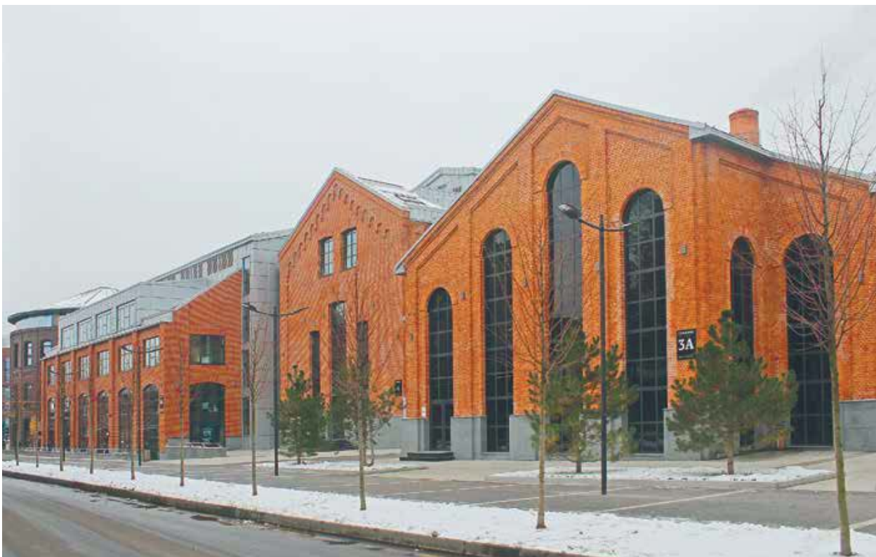
Бывшие производственные корпуса Московского газового завода
