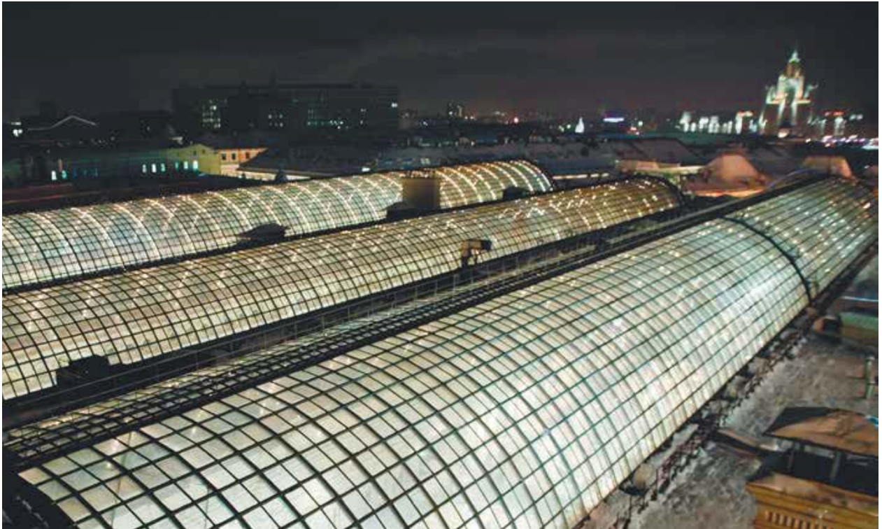
Перекрытия Верхних торговых рядов
