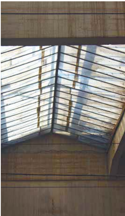
Фрагмент перекрытий. Внутреннее остекление
