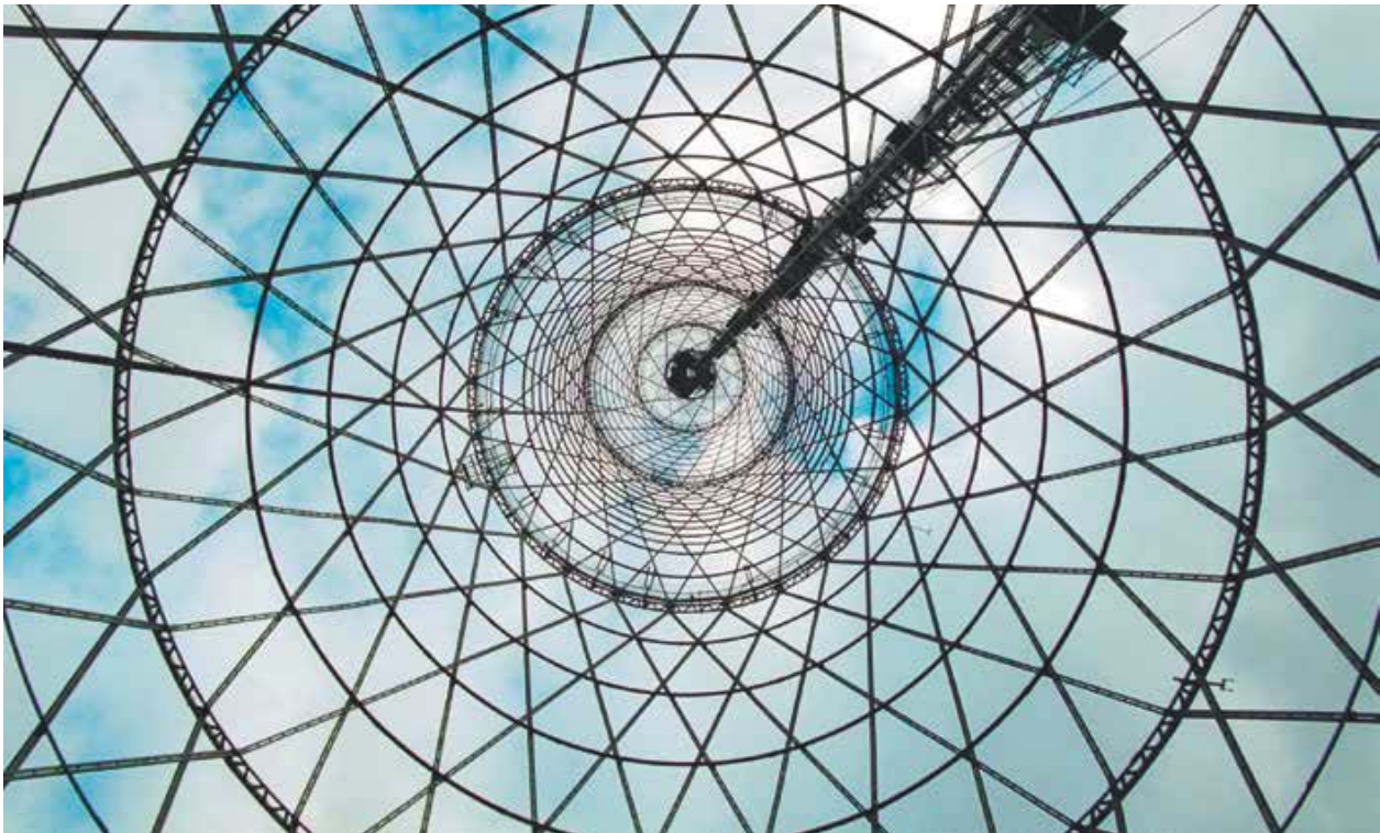
Геометрия конструкции башни
