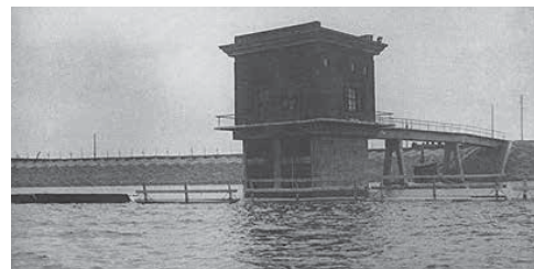
Истринская плотина. Башня донного водоспуска. Московская область, Россия
