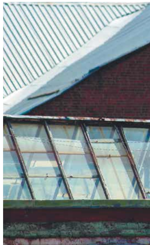
Фрагмент крыши здания депо
