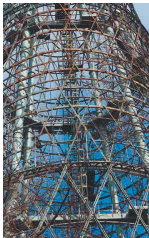
Фрагмент конструкции башни
