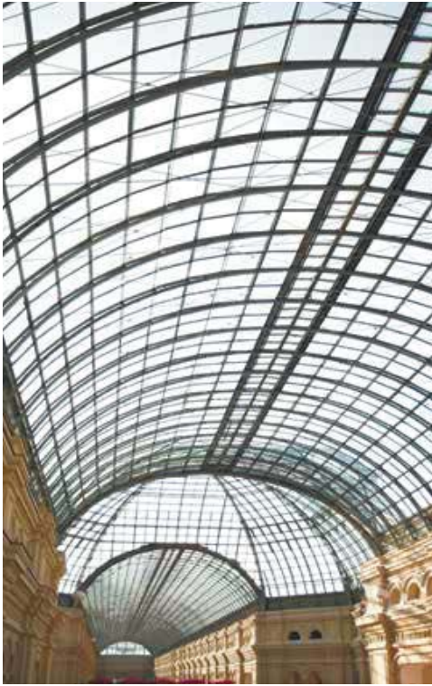
Фрагмент перекрытий центральной линии
