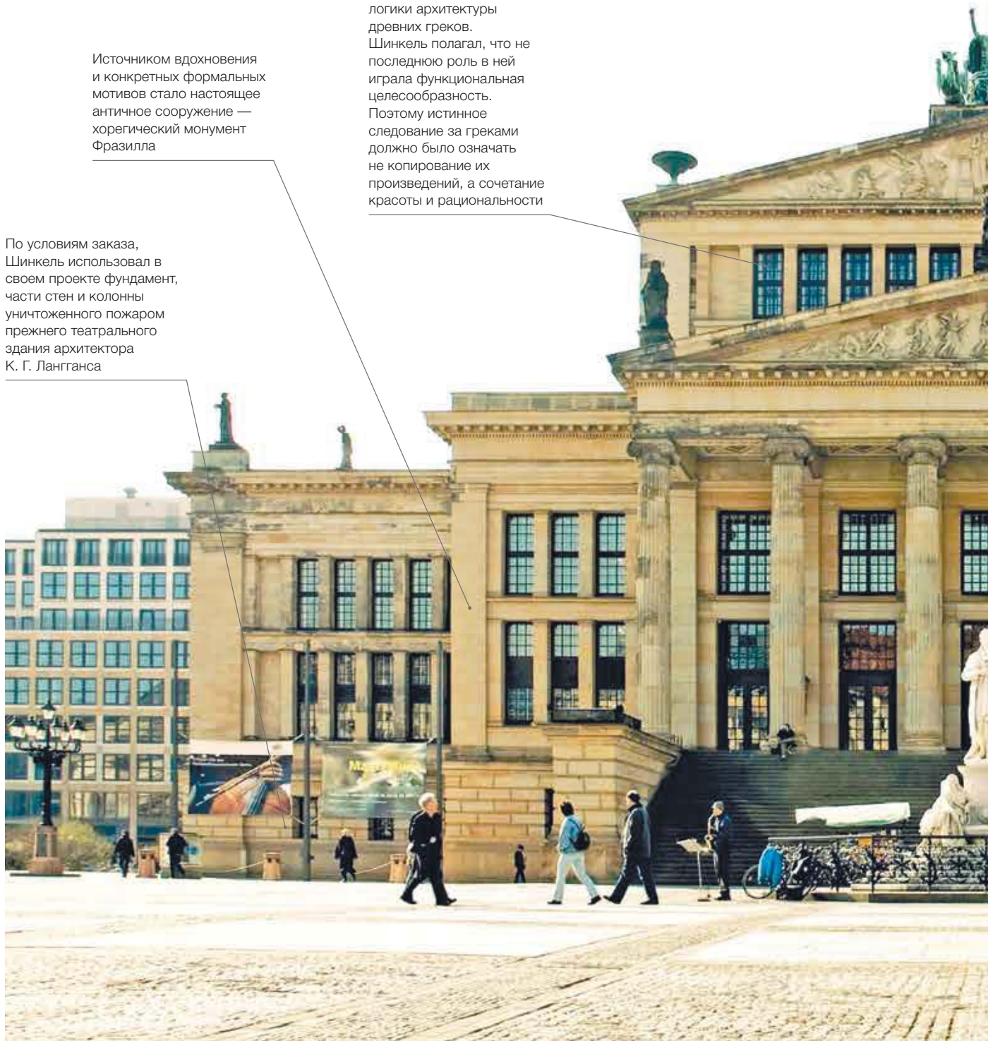
Берлинский драматический театр (ныне Концертхаус). Главный фасад
