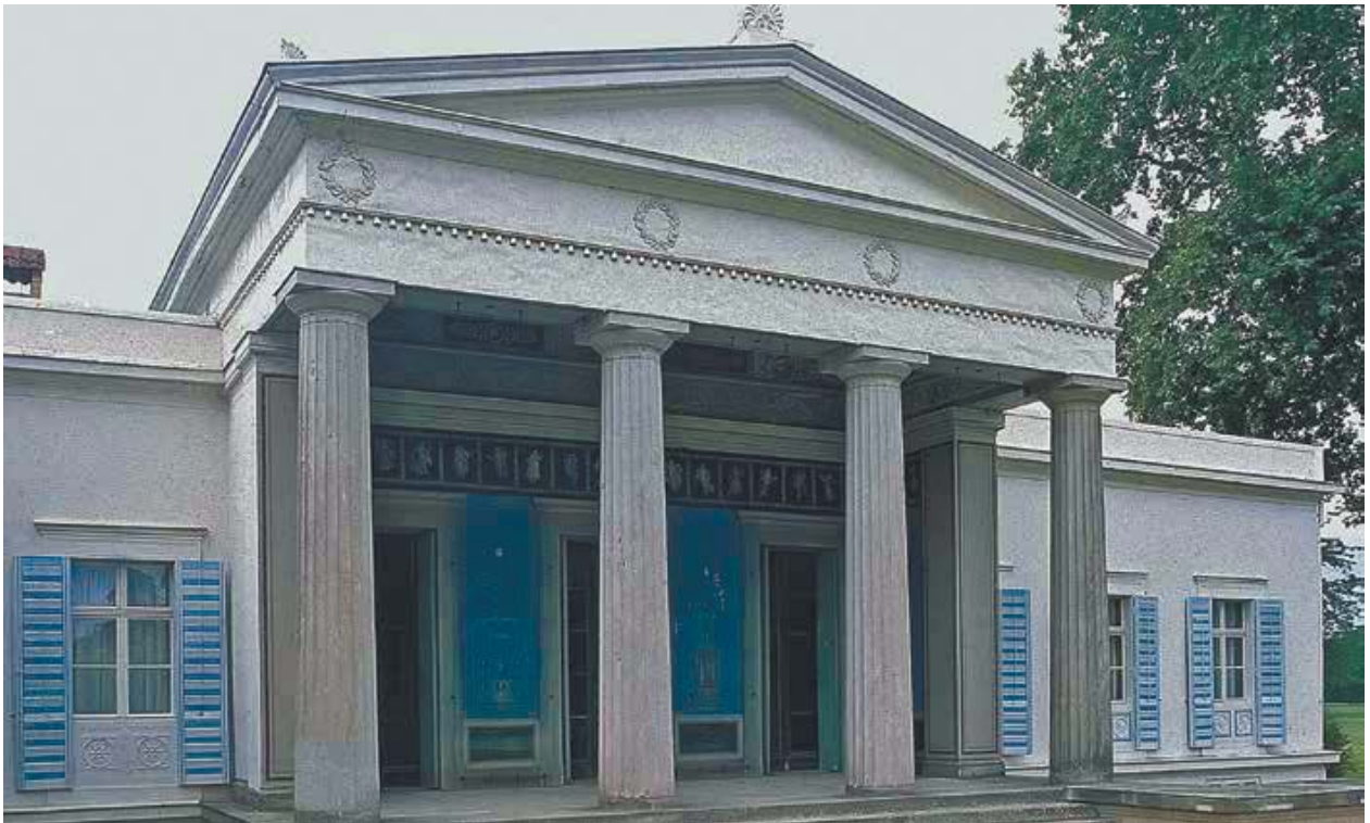
Дворец «Шарлоттенхоф». Портик главного фасада. Потсдам, Германия
