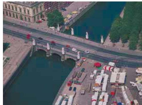
Дворцовый мост. Аэросъемка
