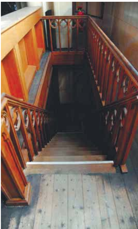
Деревянная несущая аркада галереи и обработка лестницы
