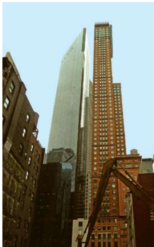
«Карнеги-холл-тауэр». Торцевой фасад, Нью-Йорк, США
