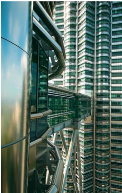
Мост. Вид сбоку
