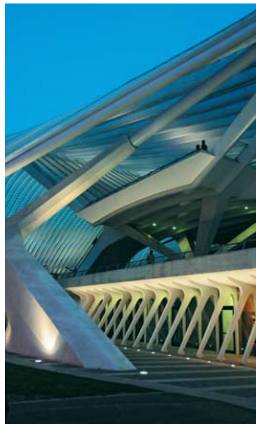
Бетонные опоры крыши вокзала
