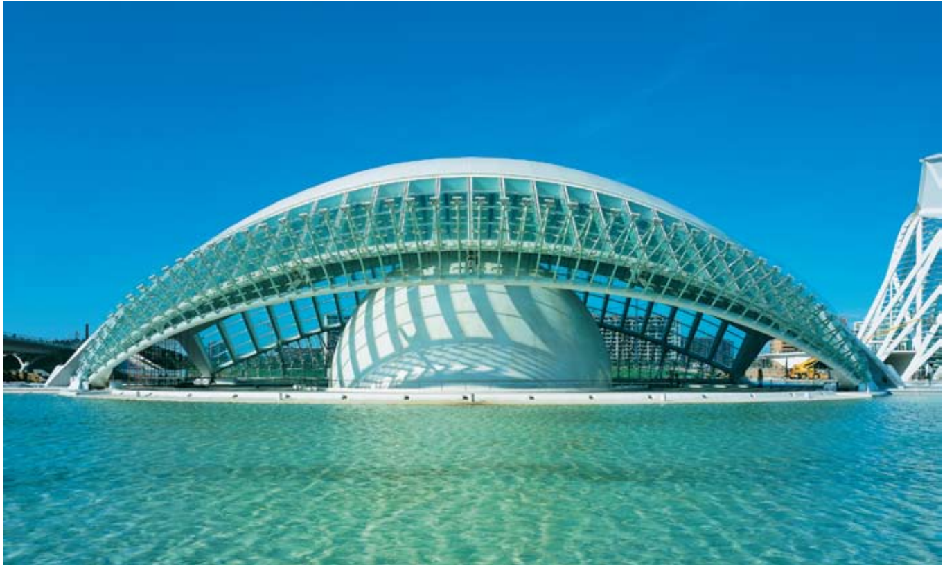
Главный фасад кинотеатра-планетария «Полушарие» с открытой стеклянной стеной-трансформером
