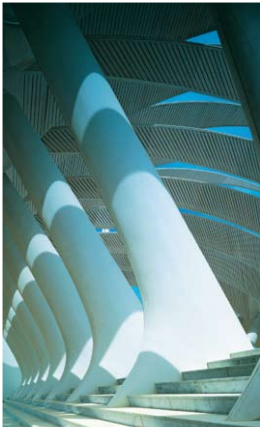
Несущие опоры из белого бетона павильона Кувейта
