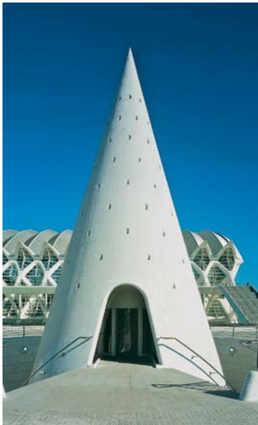
Башня с лифтом для подъема с подземной стоянки
