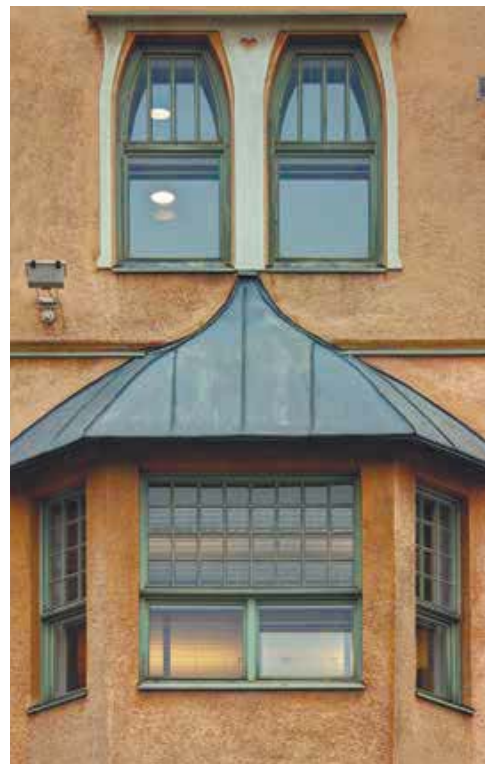
«Дом врачей». Фрагмент фасада. Трапециевидный эркер
