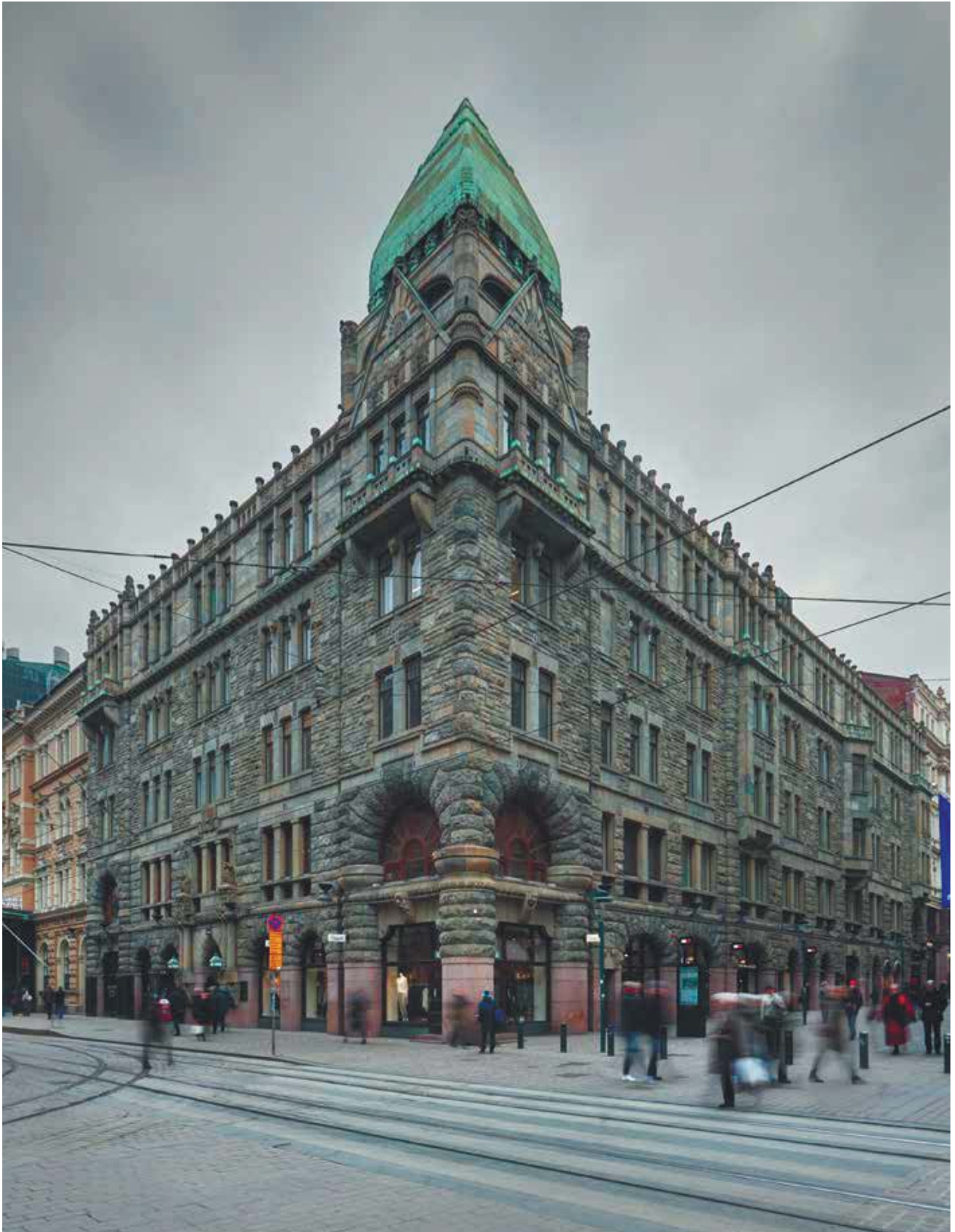
Здание страхового общества «Похьола». Общий вид. Хельсинки, Финляндия
