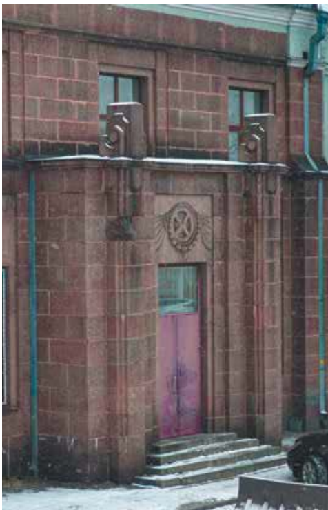
Сохранившийся фрагмент фасада вспомогательного здания железнодорожного вокзала в Выборге
