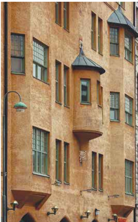
«Дом врачей». Фрагмент фасада. Полукруглый эркер второго этажа
