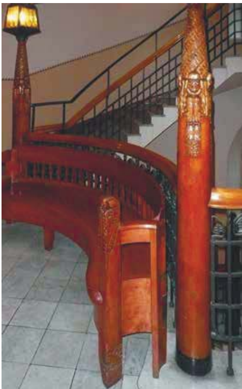
Здание страхового общества «Похьола». Встроенная лестница на лестничной площадке
