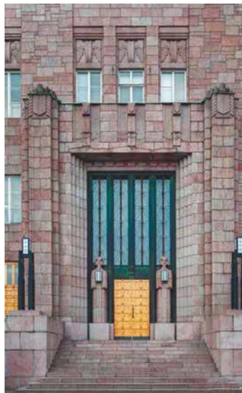
Фрагмент бокового (восточного) фасада. Портал служебного входа
