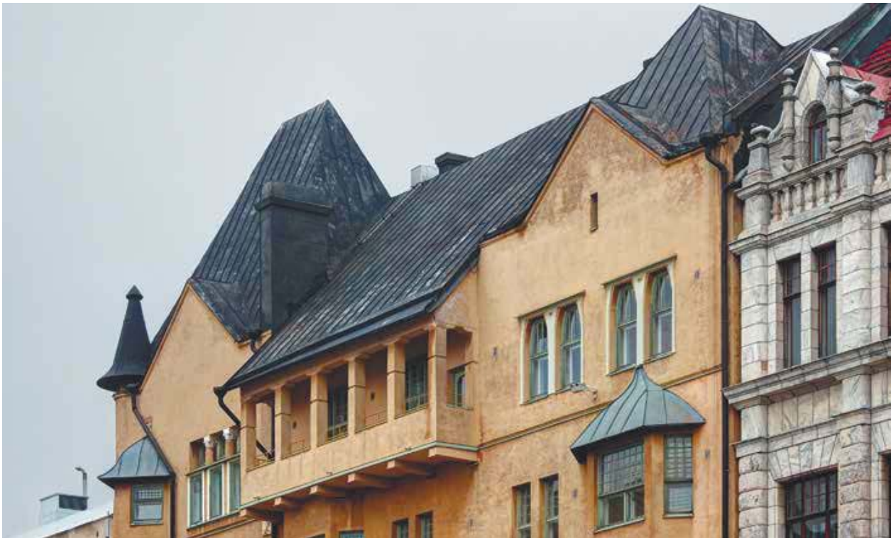
«Дом врачей». Фрагмент фасада. Балкон
