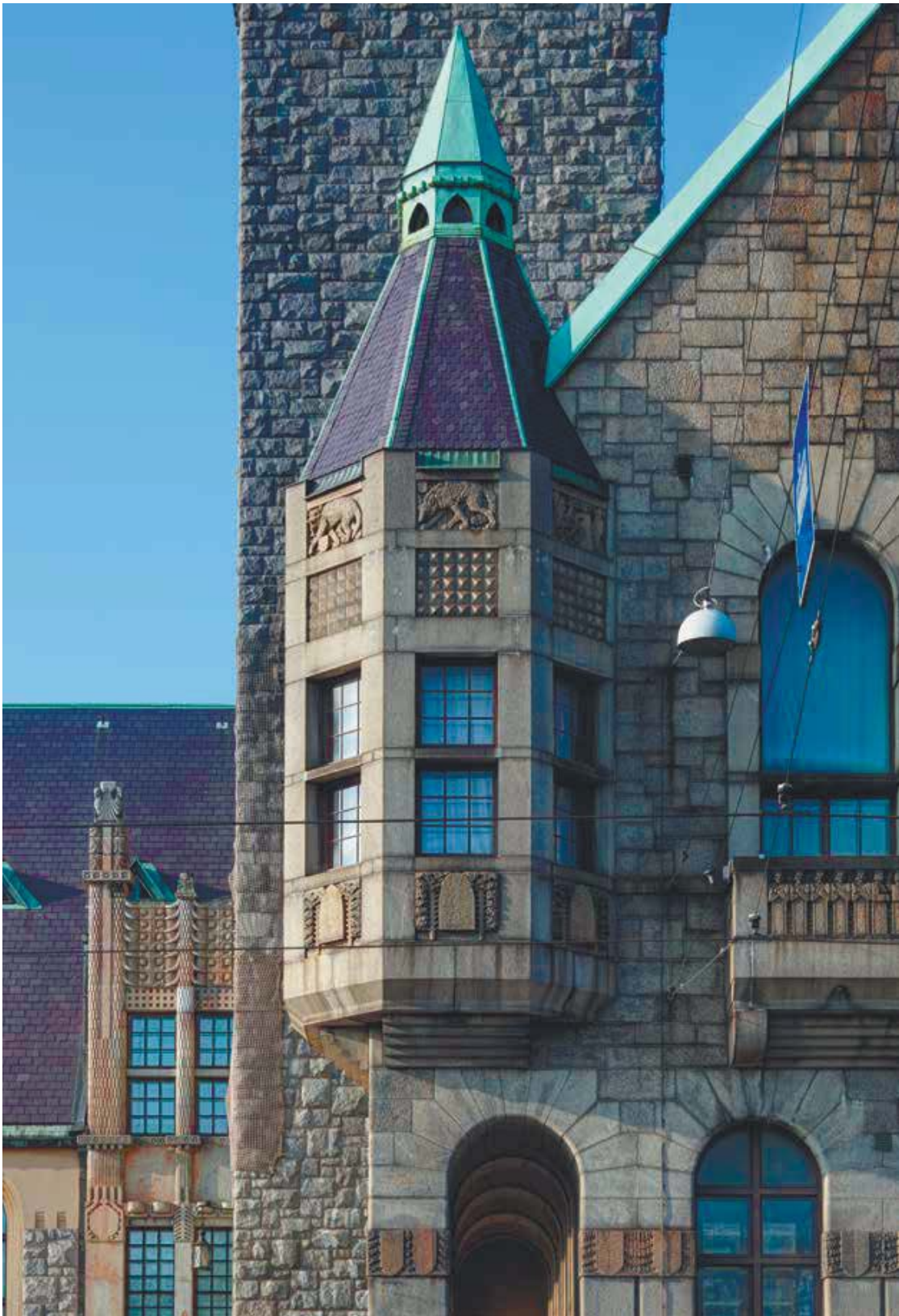
Национальный музей. Фрагмент фасада. Угловой эркер с шатровым завершением, декор
