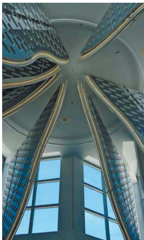
Сложная конструкция свода
