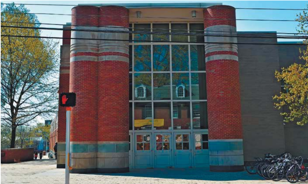
Студенческий Трабант-центр. Главный фасад
