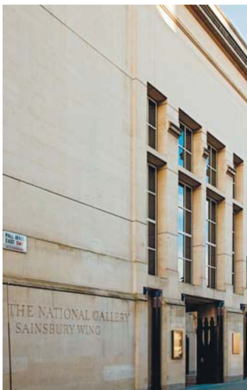
Фрагмент фасада крыла Сэйнсбери
