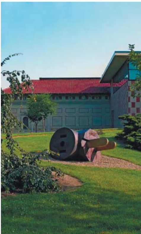
Стыковка фасадов старой и новой частей музея
