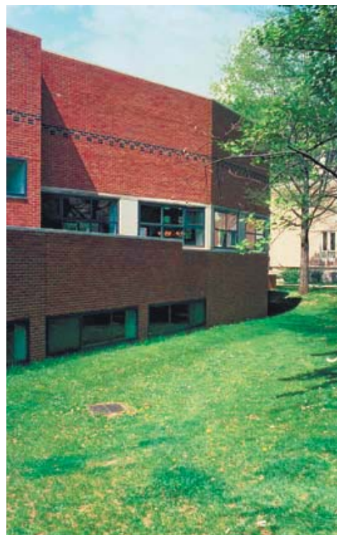
Задний фасад Гордон Ву-Холла
