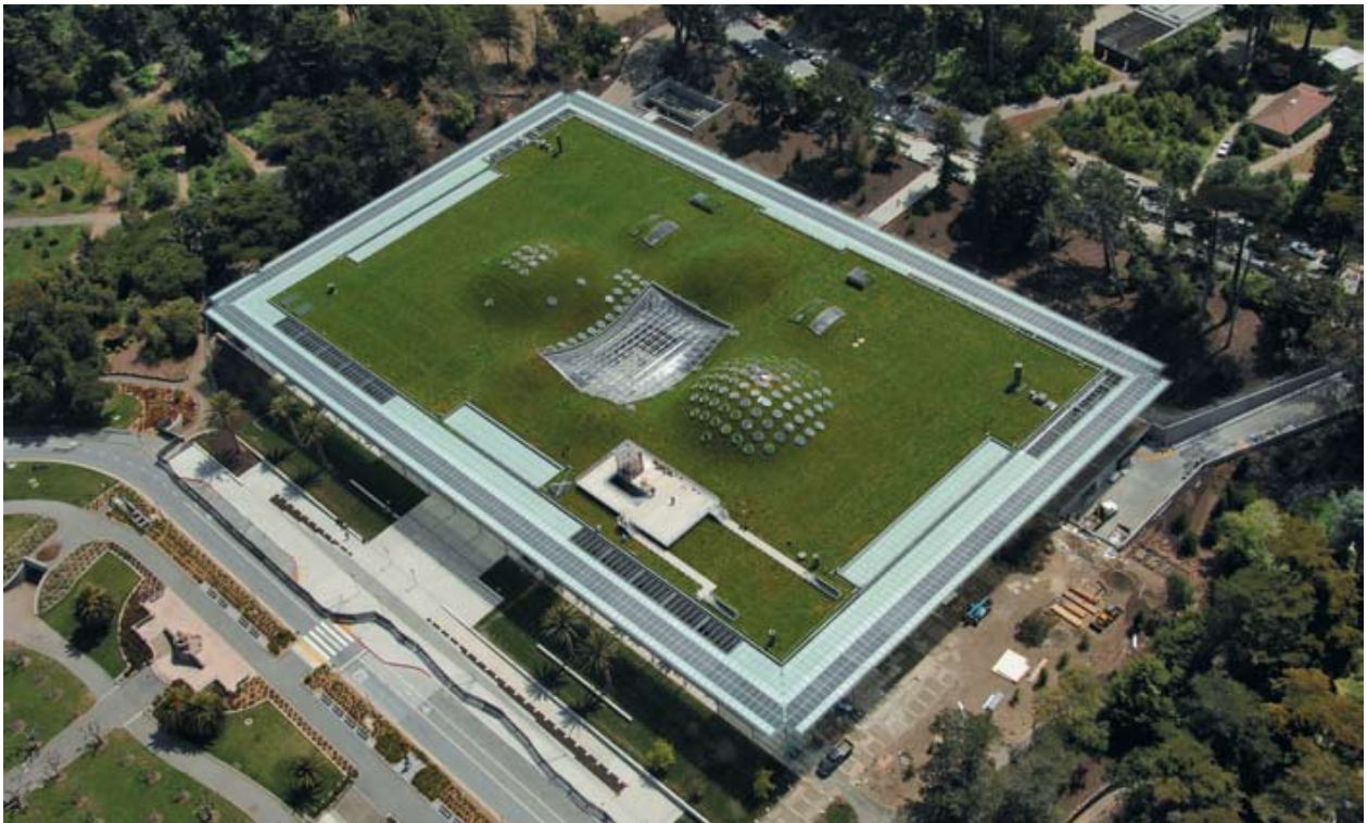
Кровля здания. Общий вид
