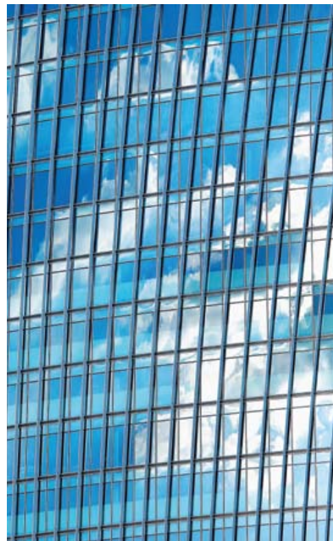
Остекление фасада. Фрагмент
