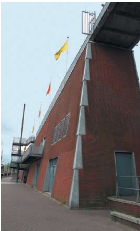
Музей NEMO. Опора пешеходного моста
