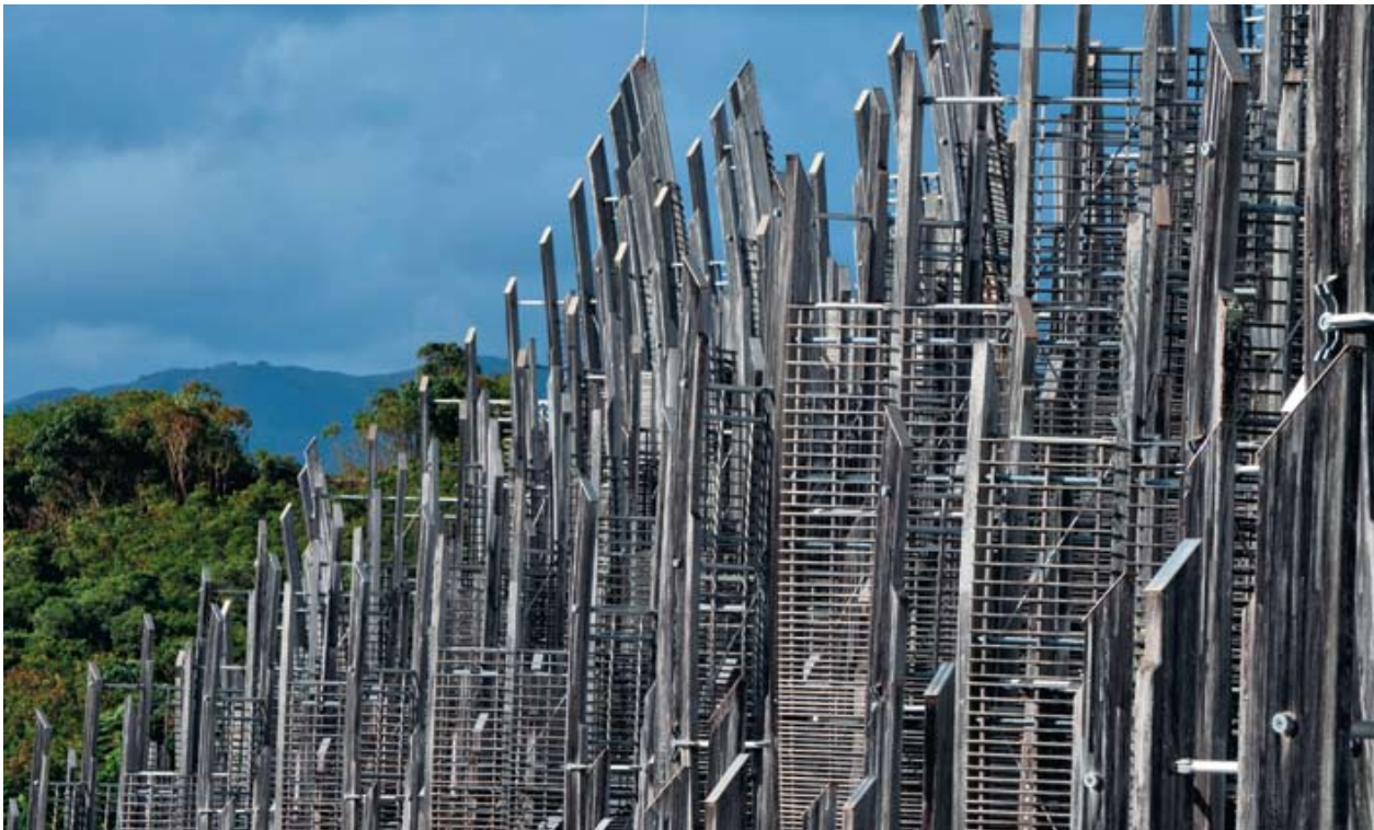
Фрагменты деревянных конструкций завершения блоков
