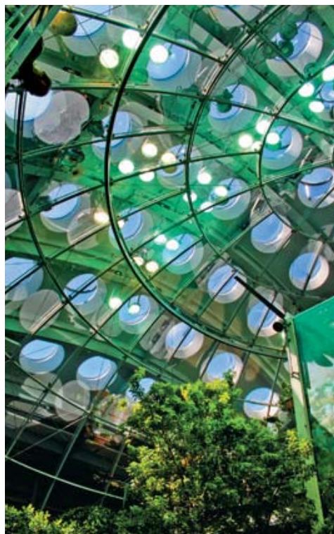
Кровля с круглыми световыми фонарями. Фрагмент
