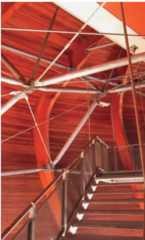
Элементы внутренней обшивки здания
