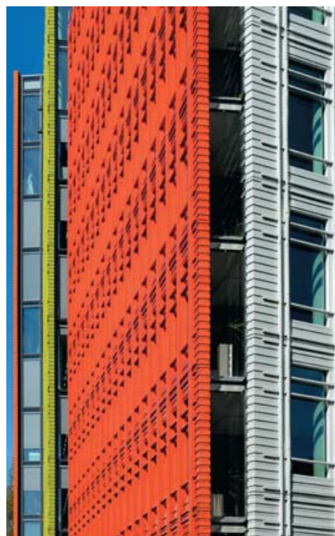
Фасад административно-жилого комплекса «Central Saint Giles». Фрагмент
