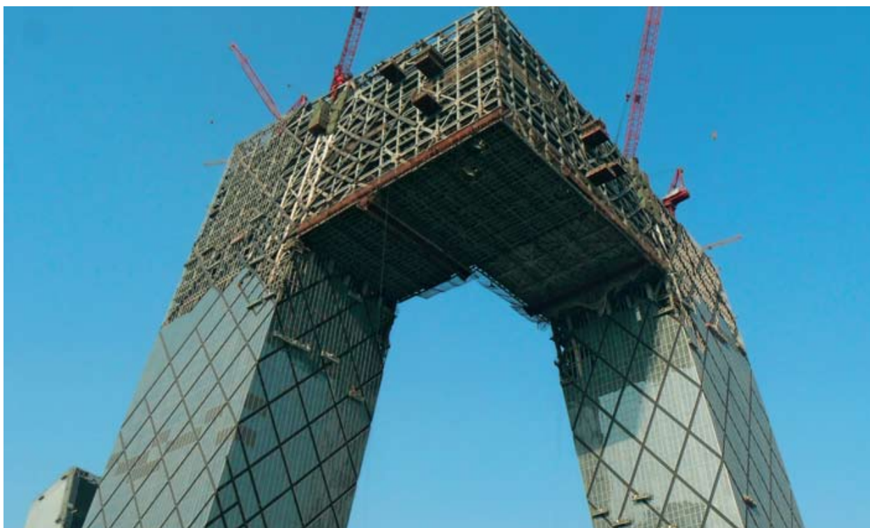
Здание в момент строительства
