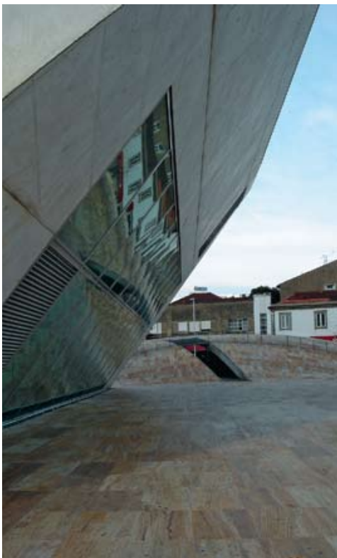
Фрагмент наклонного фасада
