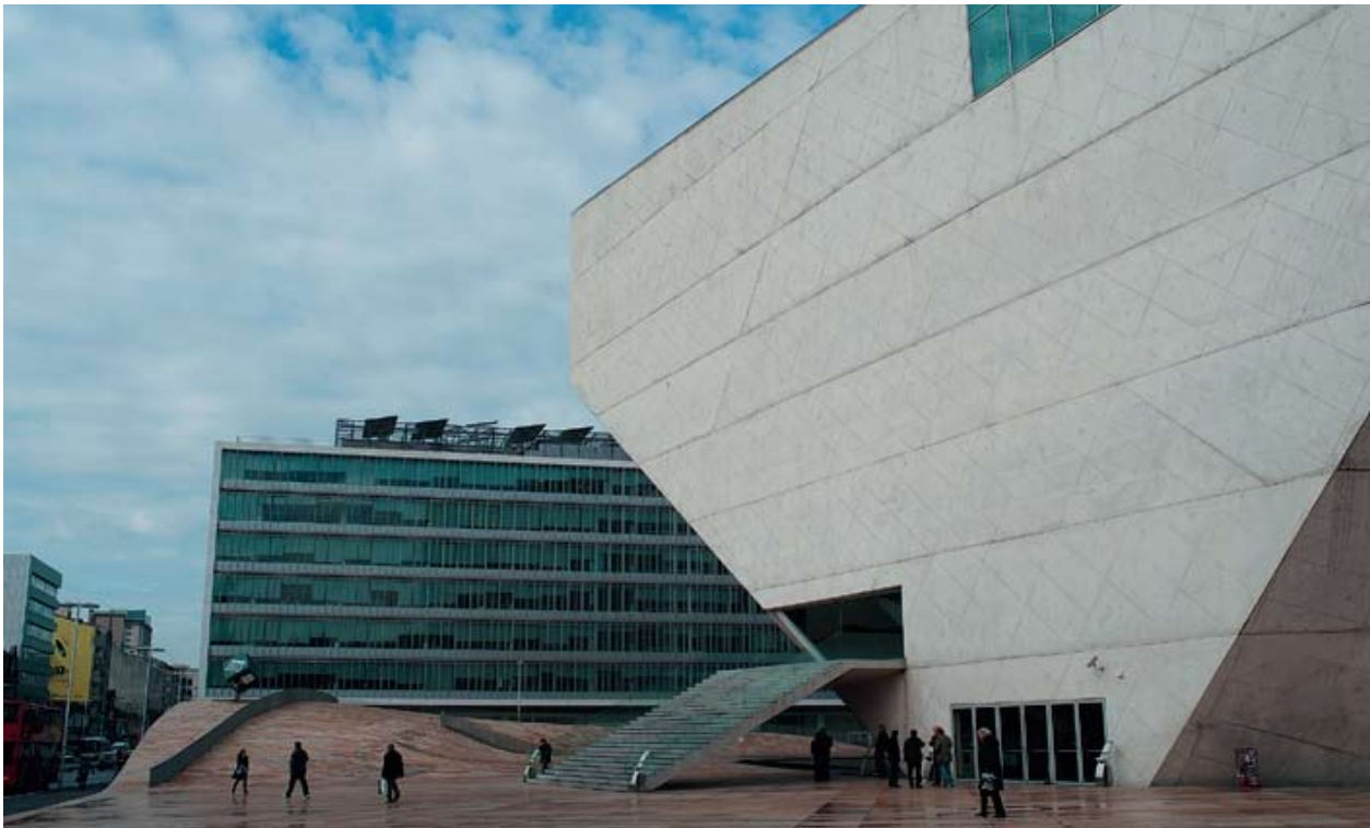
Плато из травертина, на котором стоит здание
