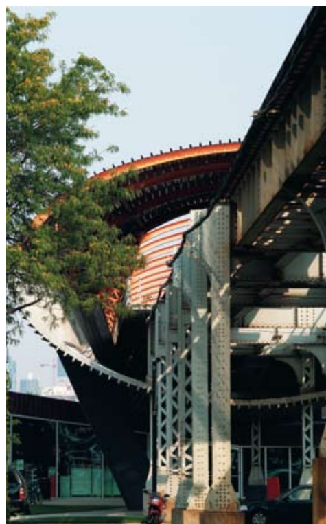
Стальной цилиндр, в который заключена станция метро
