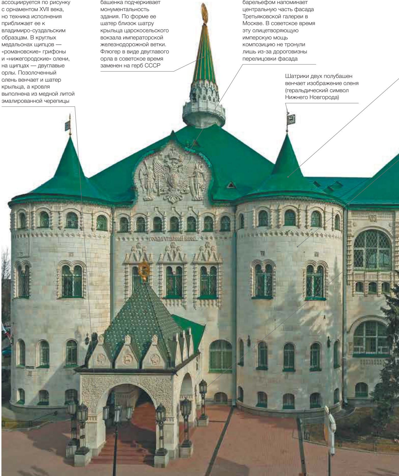
Главное здание Государственного банка в Нижнем Новгороде. Фасад по Большой Покровской улице
