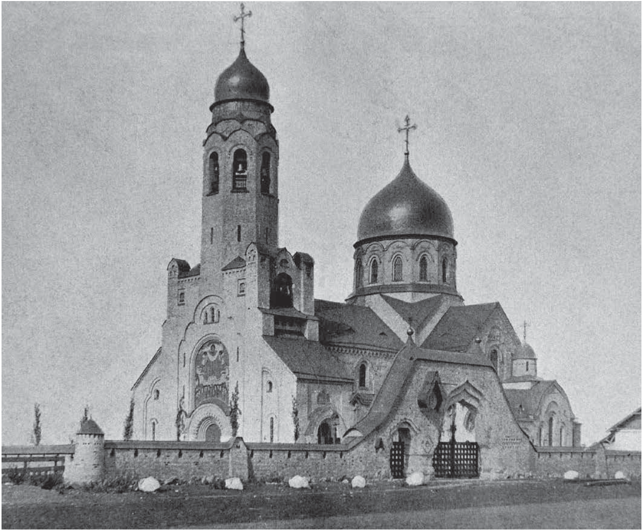
Церковь Покрова в Пархомовке. Вид с юго-запада. Фото 1908 г.
