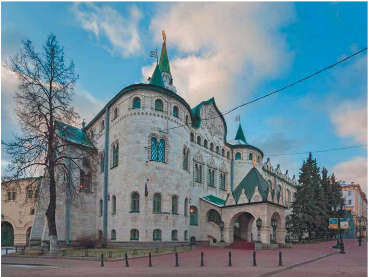
Главное здание Государственного банка в Нижнем Новгороде. Вид с угла Большой Покровской и Грузинской улиц
