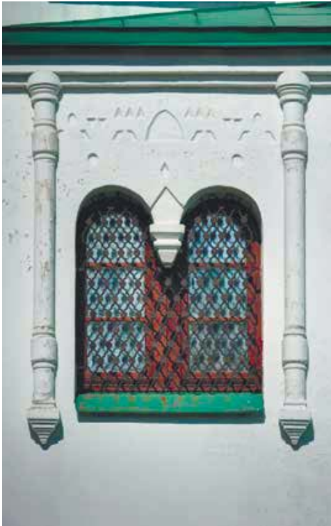
Фрагмент южного фасада
