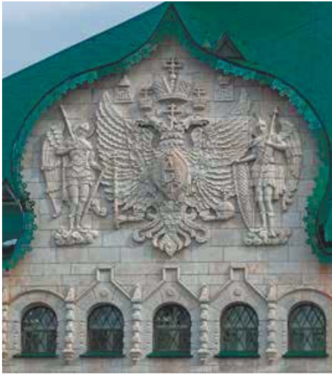
Главное здание Государственного банка в Нижнем Новгороде. Фрагмент фасада по Большой Покровской улице
