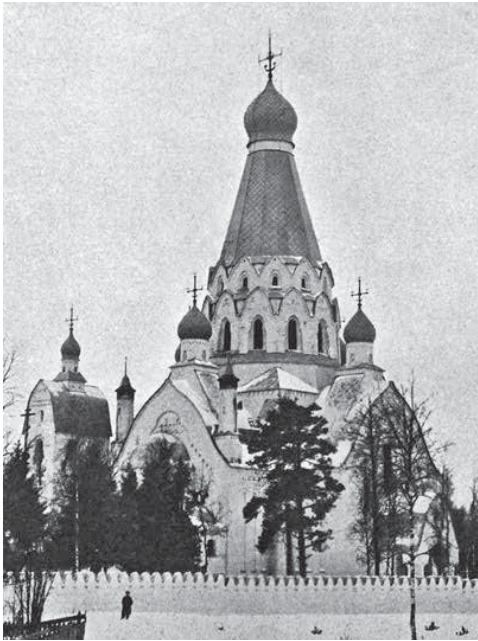
Церковь Петра и Павла на Шлиссельбургских пороховых заводах. Вид с северо-востока. Фото 1907 г.
