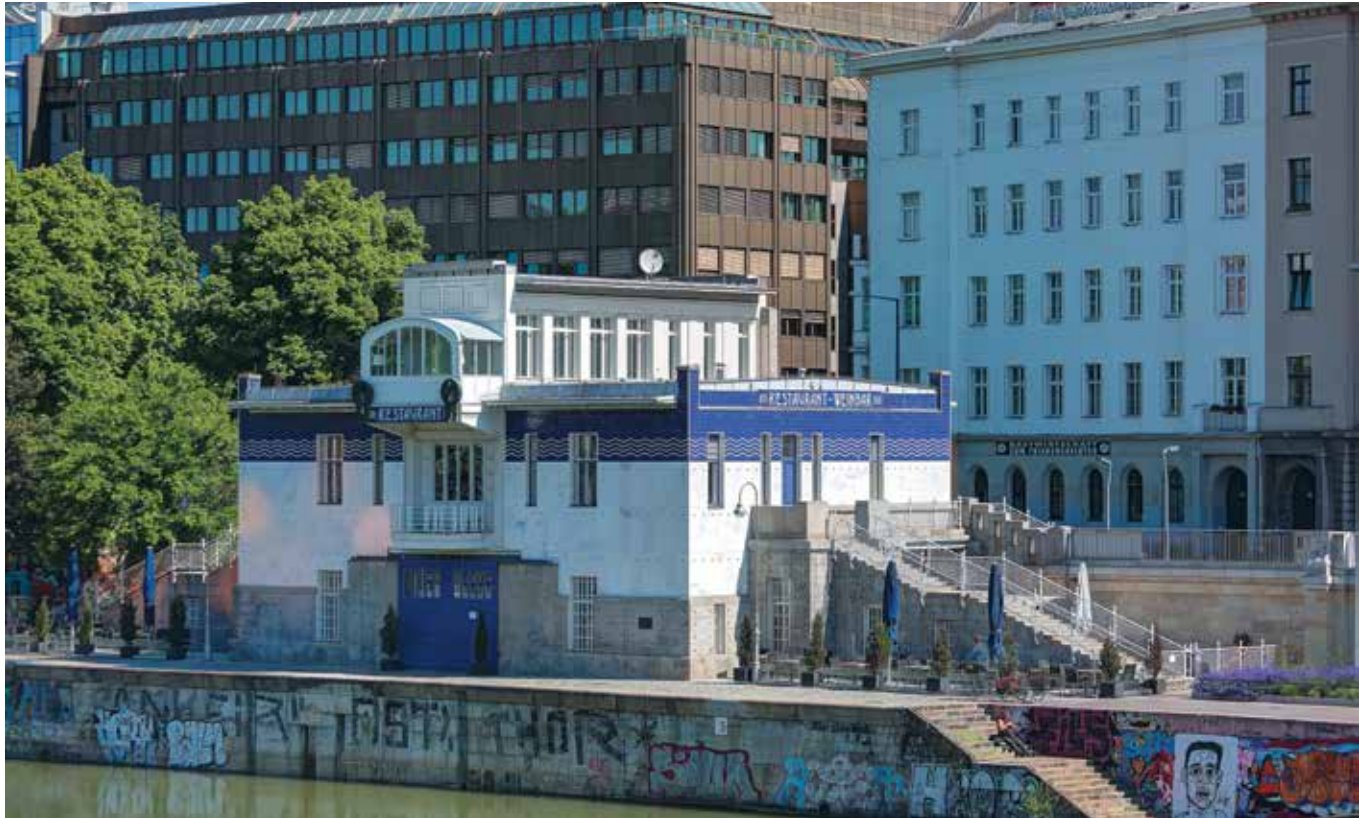
Кайзербадский шлюз на Дунайском канале. Общий вид
