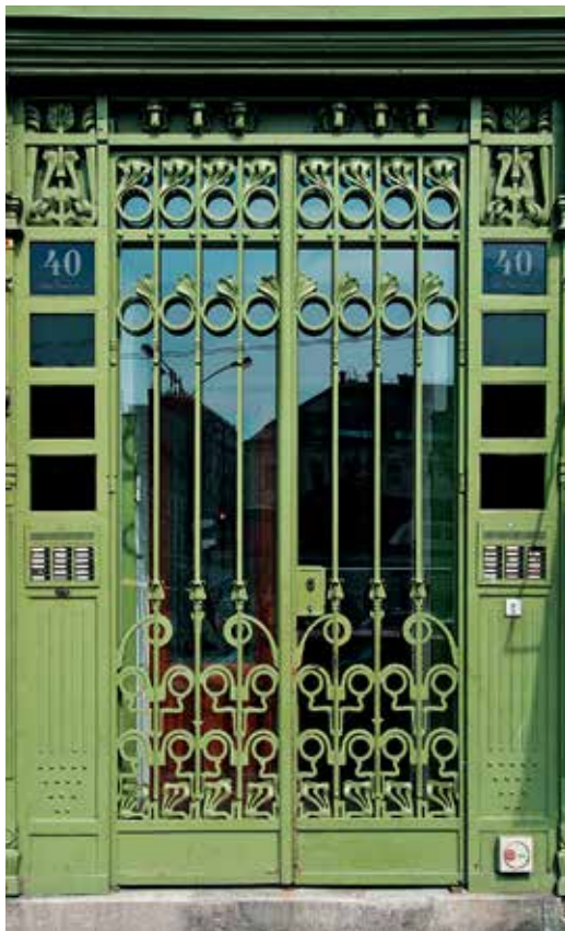
Входные двери парадного подъезда
