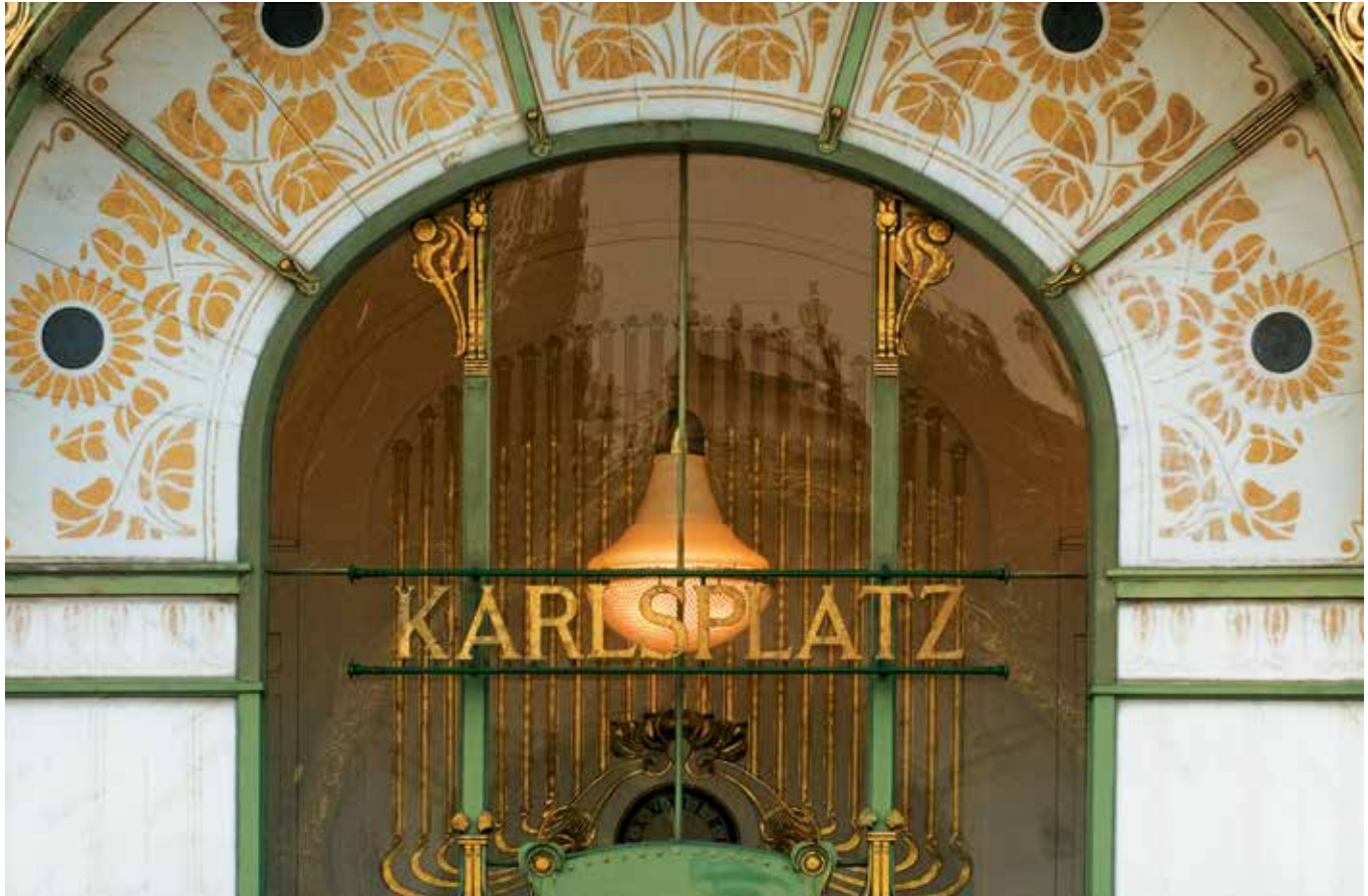
Детали обработки главного фасада
