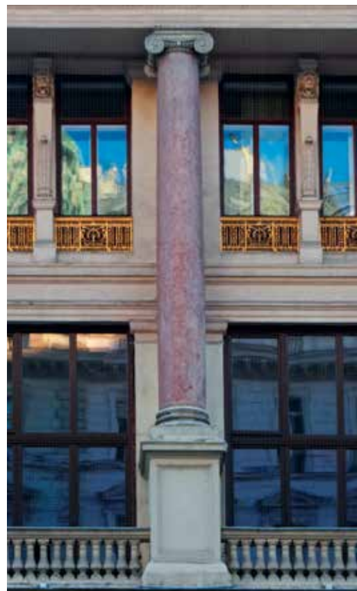
«Грабенхоф». Ионическая колонна в обработке фасада
