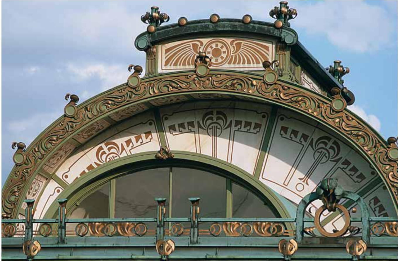
Декоративная отделка кровли павильона станции «Карлсплац»
