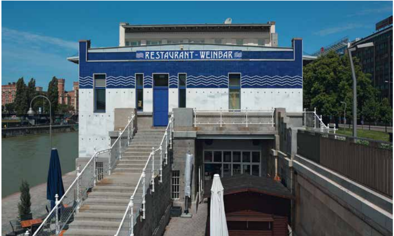
Кайзербадский шлюз на Дунайском канале. Здание шлюзных ворот. Вена, Австрия
