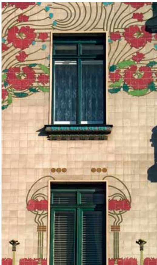
Деталь фасада. «Графическая» обработка оконных проемов
