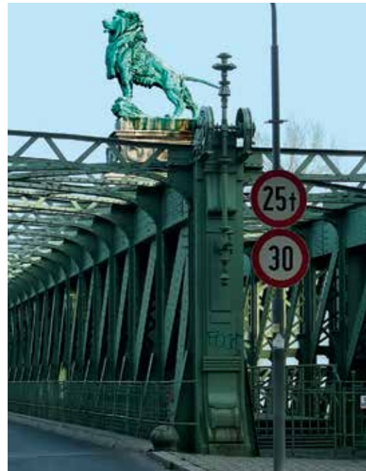
Мост над Нуссдорфским шлюзом. Металлические конструкции
