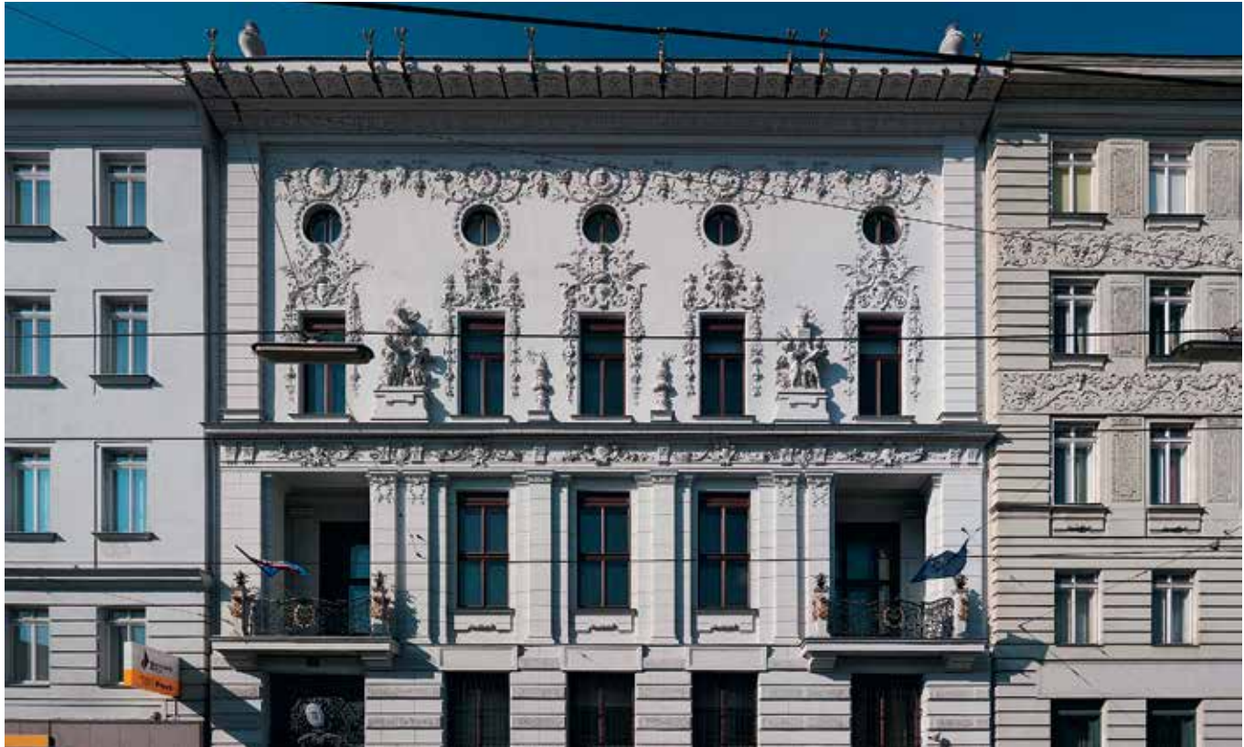
Дворец Ойос (изначально собственный дом-ателье Вагнера). Фрагмент главного фасада
