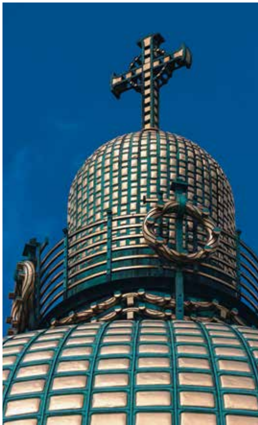
Декоративная облицовка купола
